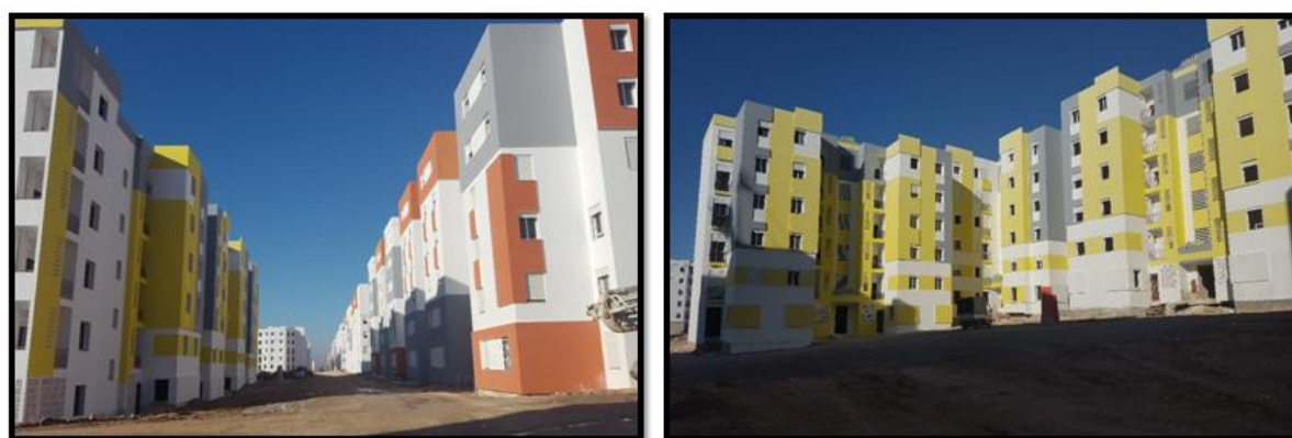
Figure 84 Projet : 4000 logement Ain Abid « Entreprise chinoise (CSE), Réception : Février 2018 , source Auteur
