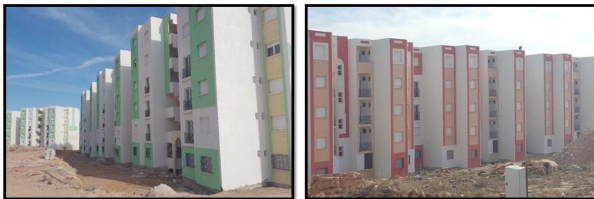
Figure 83 Projet : 4000 logements Extension Ouest, Nouvelle ville « Entreprise Turque (KUR-INSHAT), Réception : Février 2018 » source Auteur
