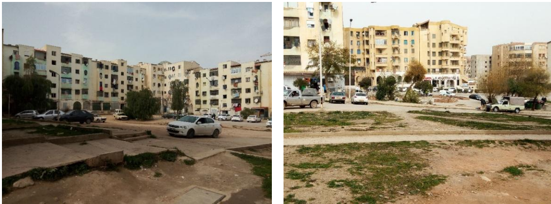
Photo 54 : Représentant l'emplacement des places et leur aménagement au sein de la ville nouvelle Ali Mendjeli.
