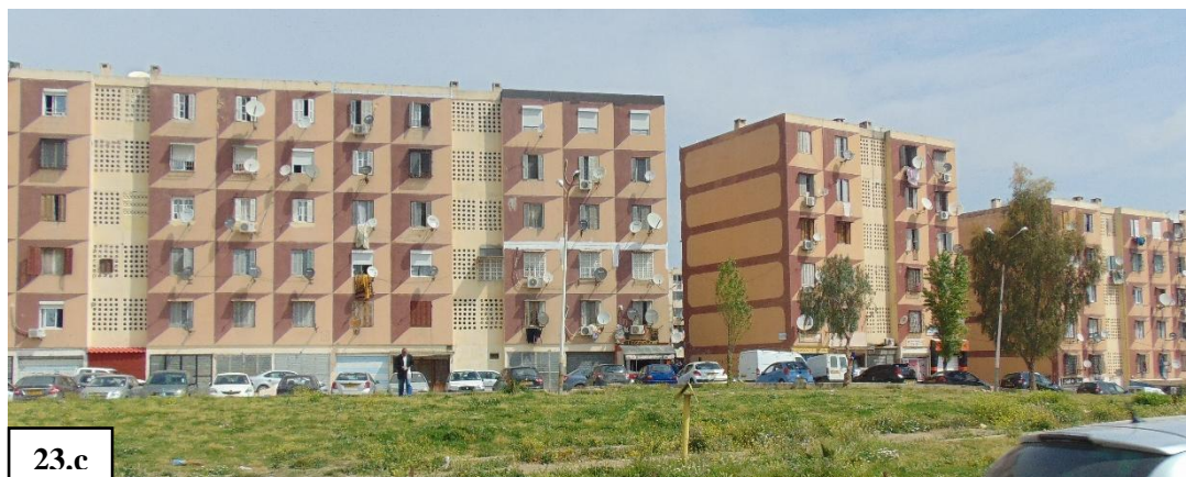
Photo 23 : Illustrant le model de construction, réparti en différentes zones de la ZHUN. Source : Prises de photos le 16 septembre 2016.
