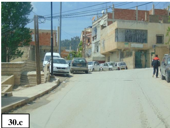
Photo 30 : Illustrant le modèle du cadre bâti au niveau de la cité Bencherghui.
