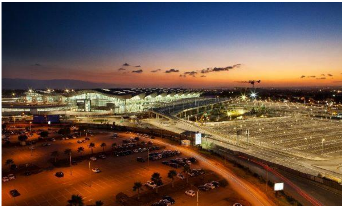
Figure 3.10. Le nouvel aéroport international Houari Boumediene, lancé en décembre 2012, et inauguré en Avril 2019.
