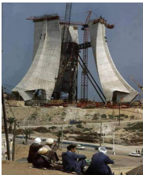
Figure 3.1. Travaux de réalisation du Monument de Ryadh El Fath, entre 1981 et 1982.
