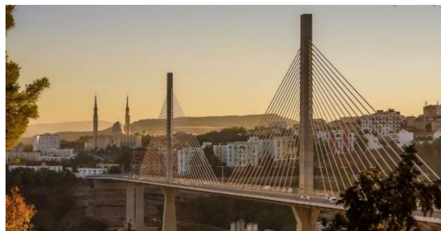
Figure 2.27 Le pont Trans-Rhumel.
