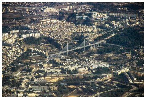
6. 3 Vue en haut sur le viaduc Salah Bey
