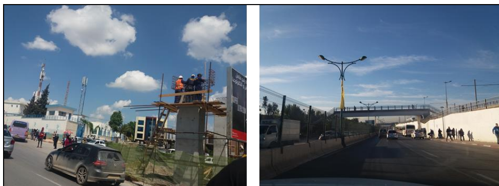
7. 19 Création d'une passerelle pour faciliter l'accès à l'arrêt de bus et de tramway (Source :Auteure,5/2018 ; 11/2018)
