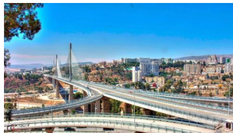
6. 2 Viaduc Salah Bey
