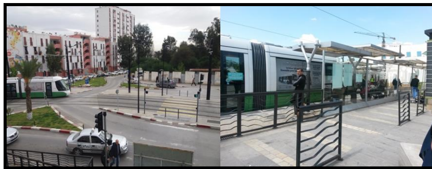
7. 22 Signalisation, feux de circulation et abris de bus du tramway
