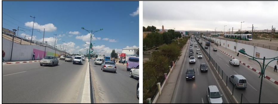
7. 18 Avant/après la structuration de la RN 3 au niveau du Zouaghi Slimane (Source :Auteure, 11/2017 ; 11/2018)
