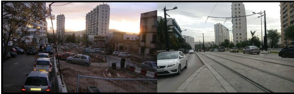
7. 16 Avant/après l'introduction de la ligne du tramway au niveau de Kadour Boumedous (Source : Boufendi, 2011 ; Auteure, 2019)
