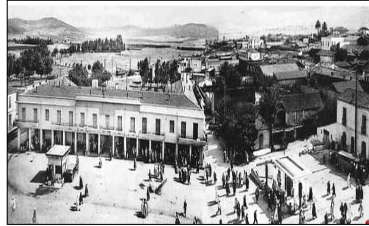
Figure 4.14. Bâtiments de la période coloniale
