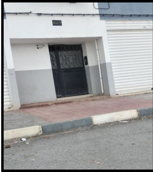
Photo N° 5.7 : La porte d'entrée de l'immeuble LPA
