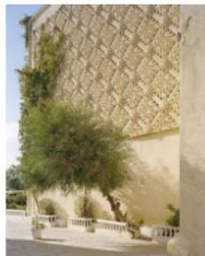
Façade en moucharabieh restaurant, port Sidi Fredj
