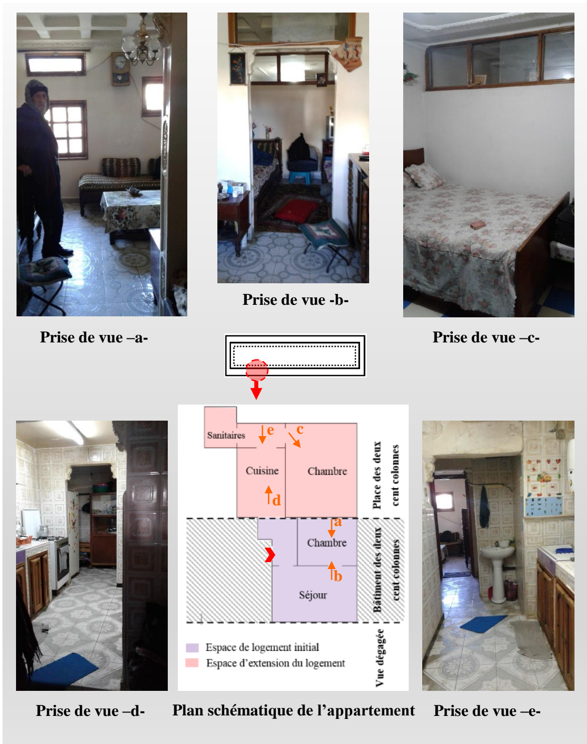
Figure IV.19. Appartement ayant subi une extension · niveau semi-enterré · bâtiment des deux cent colonnes · Climat de France · Alger.
