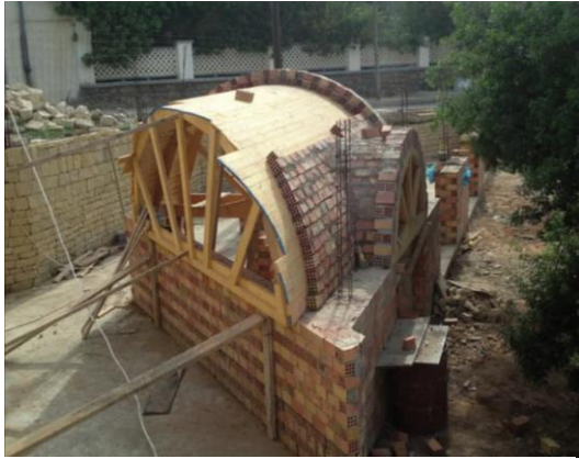
Figure V.4. Abdelhamid Si Larbi, voute en plein cintre en briques creuses sur cintre.
