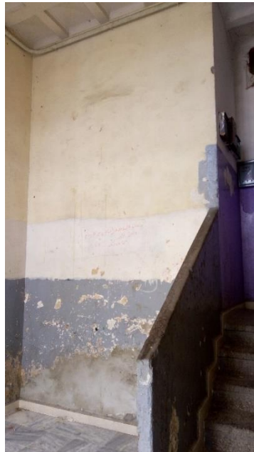
Figure IV.16. Entrée d'un immeuble à l'état original.
