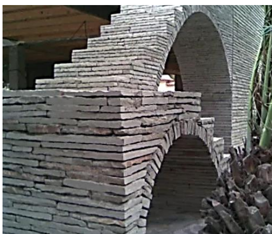
Figure VII.1. Abdelhamid Si Larbi, habitation sur la corniche oranaise, 2013-20??, disposition de la pierre dans la voute favorisant le travail de l'arc et la descente de charge.
