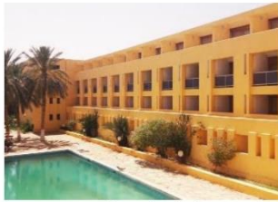
Façade sur la piscine
