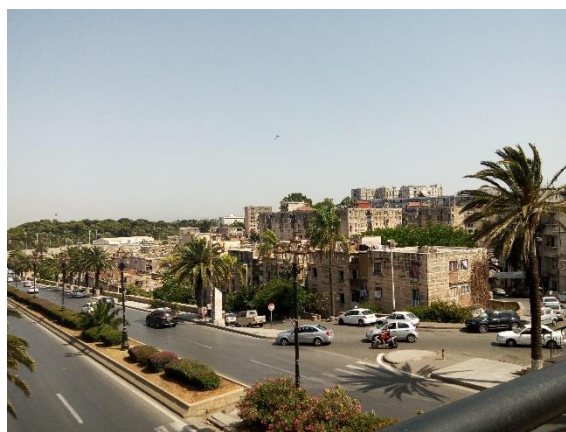
Figure II.5. Vue sur la partie Simple Confort "Mahçoul musulman", Diar El Mahçoul, 1953-1955, Alger.
