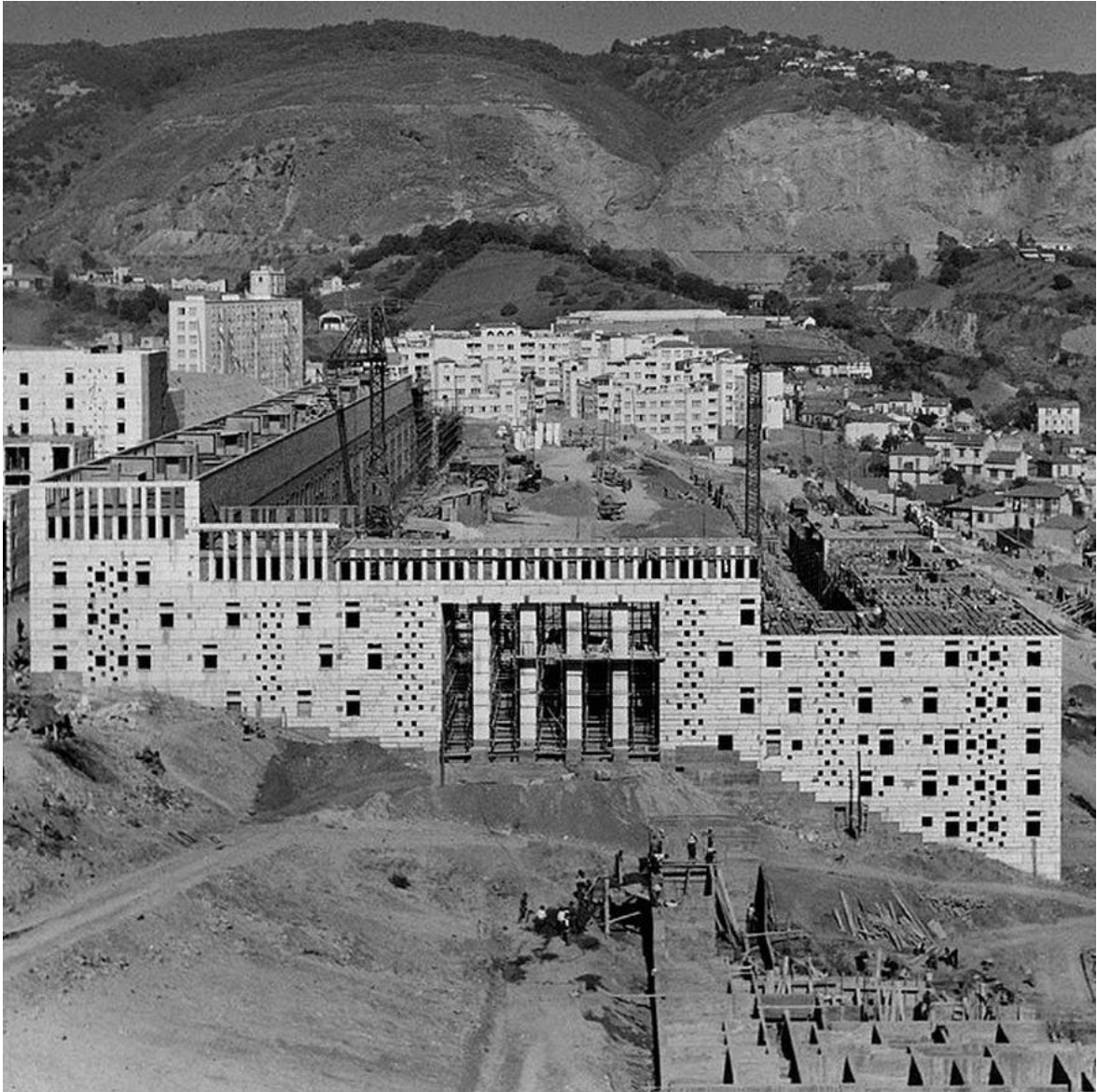
Figure IV.2. Chantier, Climat de France, 1954-1957, Alger
