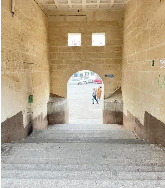
Figure IV.30. Passage couvert, Climat de France, Alger.
