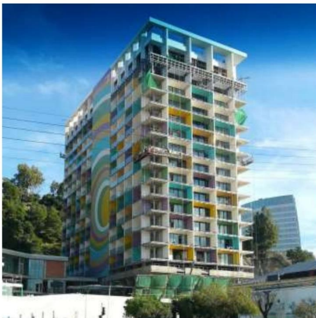
Figure 1 L'hôtel Seybouse international (Annaba) après sa rénovation (les libertés permises).
