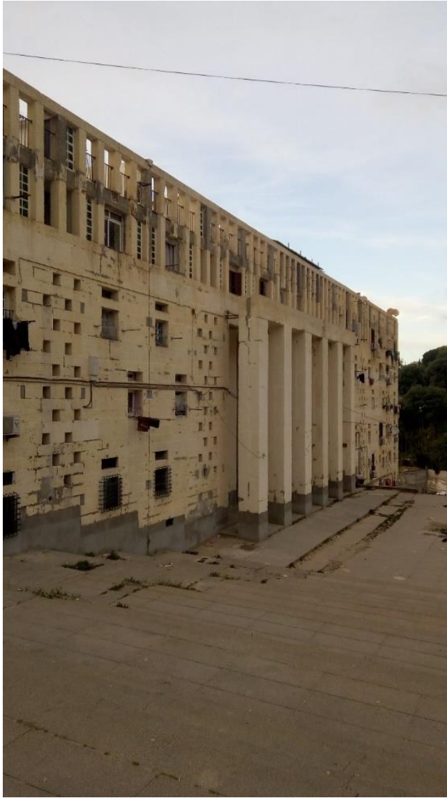
Figure II.2 Bâtiment des 200 colonnes, Façade extérieure Sud-Est, Climat de France, 1954-1957, Alger.
