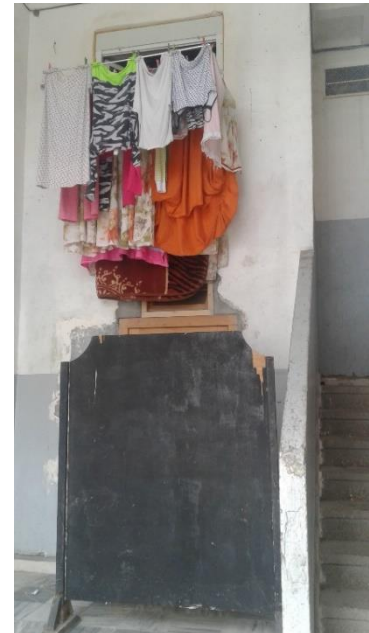
Figure IV.17. Espace squatté et transformé en logement à l'entrée d'un immeuble.
