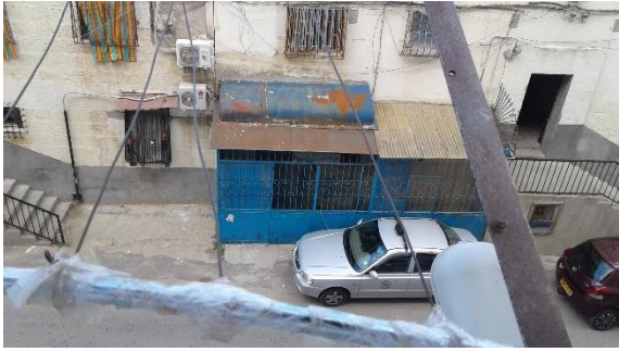
Figure IV.13. Extension illicites d'un appartement situé au RDC d'un immeuble.
