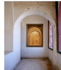
Balcon-loggia des chambres, hôtel les Rostomides, Ghardaïa
