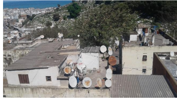
Figure IV.14. Extension illicite installée sur la terrasse d'un immeuble.
