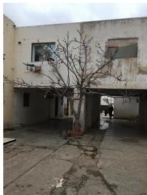
Passage à l'intérieur d'un bloc
