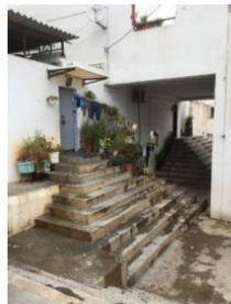
Volées d'escaliers, reprises de niveaux en même temps qu'espaces intermédiaires
