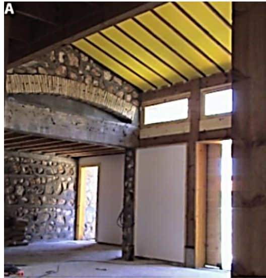
Figure VII.3. Abdelhamid Si Larbi, habitation sur la corniche oranaise, 2013-20??, utilisation de l'arc pour décharger le linteau en béton
