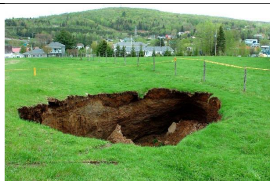
Photo 17. Affaissement de terrain. Source. http://www.developpement-durable.gouv.fr/Le-risque-mouvement-de-terrain.html , in Boumaza& al. (2015).
