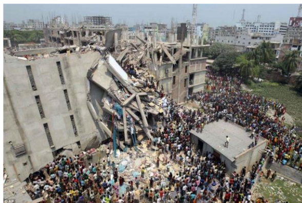
Photo 7. Effondrement d'un bâtiment au Bangladesh.2013
