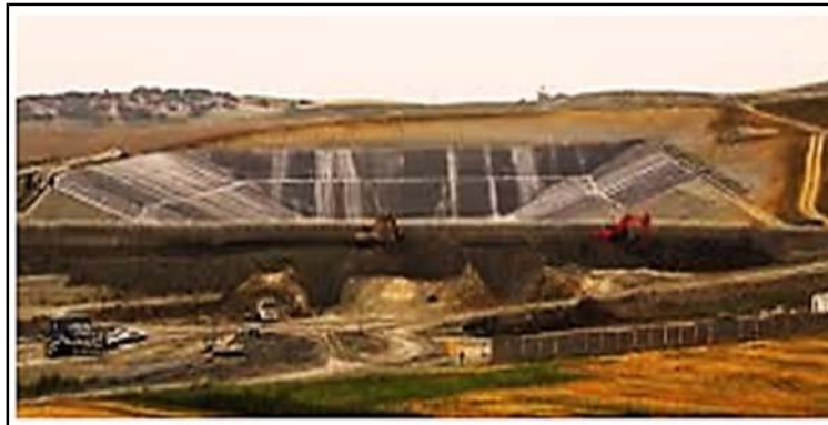
Fig 35 : Un CET en cours de Construction.
