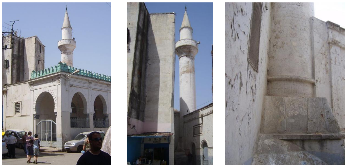
Figure 4.58. Minaret de la mosquée Saleh Bey, Annaba. (Source : Auteur, 2023)
