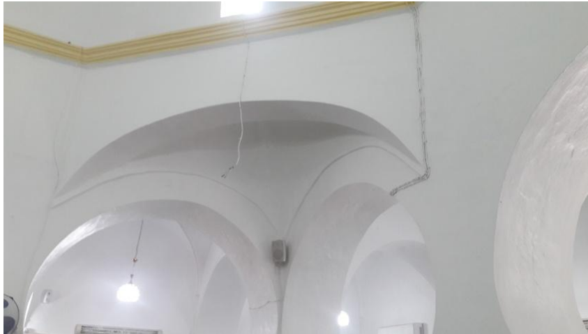
Figure 4.38. Détail du passage de la coupole au plancher. (Source : Auteur, 2023)
