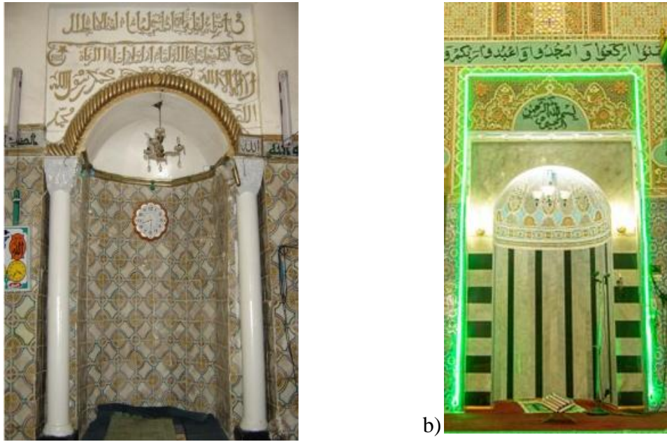
Figure 4.55. Mihrab de la mosquée du Bey, Annaba, avant et après les travaux de rénovation : a) Avant (source : Benbella, Kh, 2008). b) Après. (Source : Auteur, 2023)
