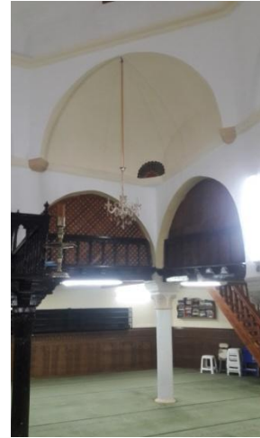
Figure 4.7. Trompes d'angle supportant la coupole centrale de la mosquée Safir. (source : auteur, 2023)
