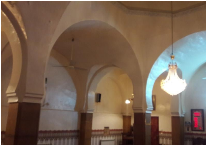
Figure 4.17. Piliers supportant la coupole centrale. (Source : Auteur, 2023)
