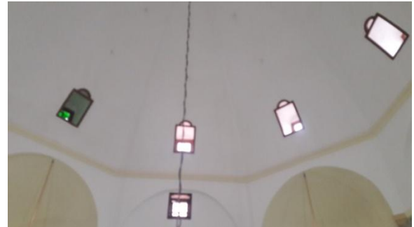
Figure 4.7. Trompes d'angle supportant la coupole centrale de la mosquée Safir. (source : auteur, 2023)
