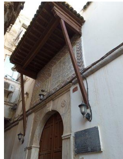
Figure 4.14. Auvent de la porte d'entrée principale. (Auteur, 2023)
