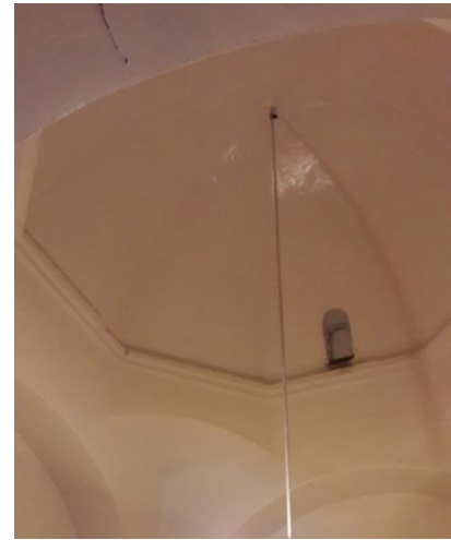
Figure 4.18. Vue de l'intérieur sur une coupole. (Source : Auteur, 2023).
