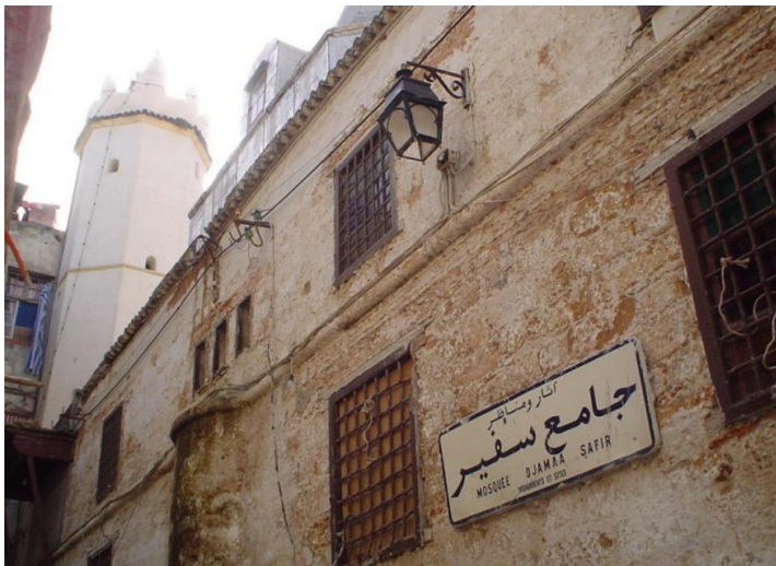
Figure 4.13. Façades de la mosquée Safir. (source : Auteur, 2023)
