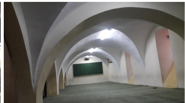
Figure 4.5. Couverture en voutes d'arrêtes des galeries latérales (source : auteur, 2023)
