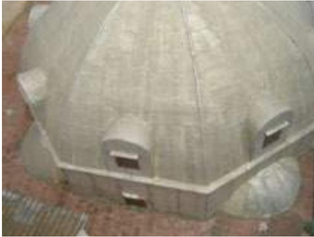
Figure 4.6. La coupole octogonale à huit pans de la mosquée Safir (Alger) et son tambour. (Source : Driouèche, 2001, page 192)
