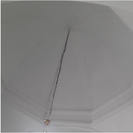
Figure 4.40. Coupolette. (source : auteur)
