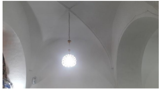
Figure 4.41. Voutes croisées supportant le plancher des quatre galeries. (Source : Auteur, 2023)
