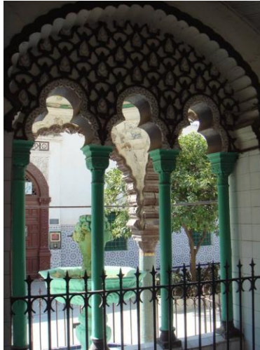
Figure 4.67. Décoration au niveau du vestibule précédant la salle de prière. (Source : Auteur, 2023)
