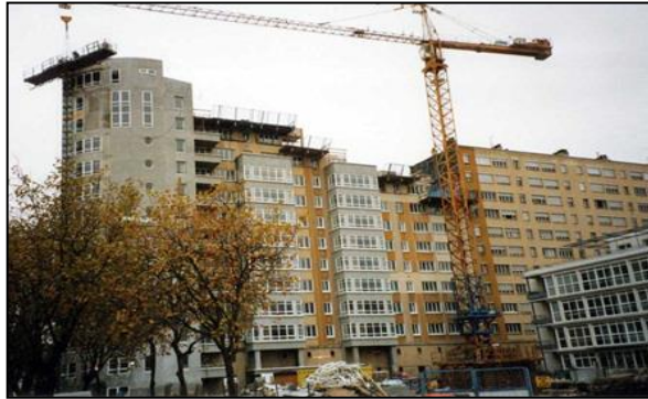
Début des travaux
