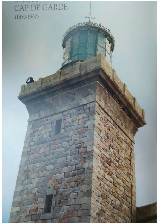
Figure 7.11. Appareillage de la pierre apparente sur la tour du phare de Cap de Garde (Annaba). Source : Belhamissi & Al, 1998.
