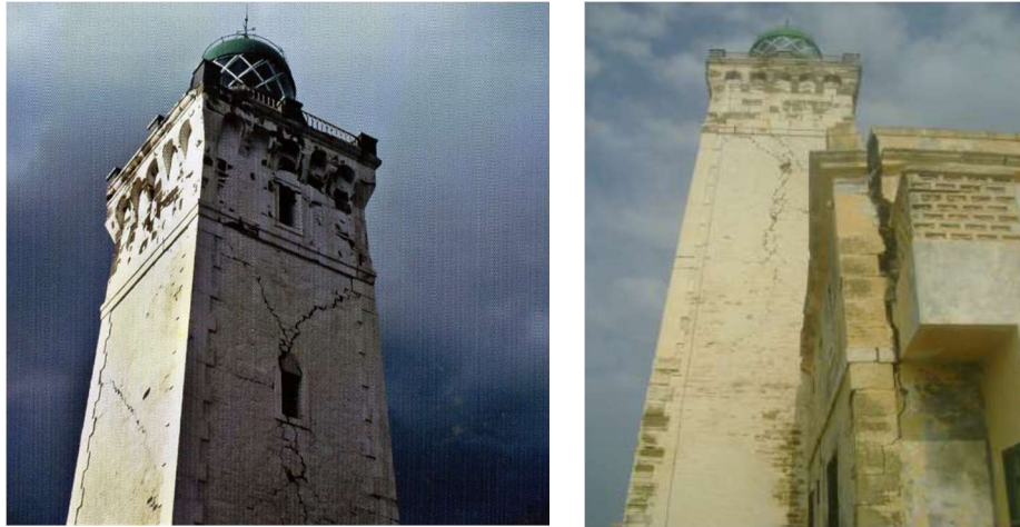
Figure 7.48. Etat du phare de Bengut après le séisme Boumerdes 2003. Source : ©Hichem Bekhti.s.d.
