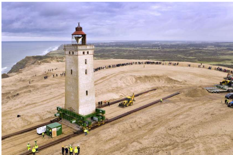
Figure 4.11. Phare de Rubjerg Knude au Danemark, déplacé de 70 mètres grâce à des rails. Source : Marie Dorsaz, www.lenouvelliste.ch , consulté le 20/12/2012.
