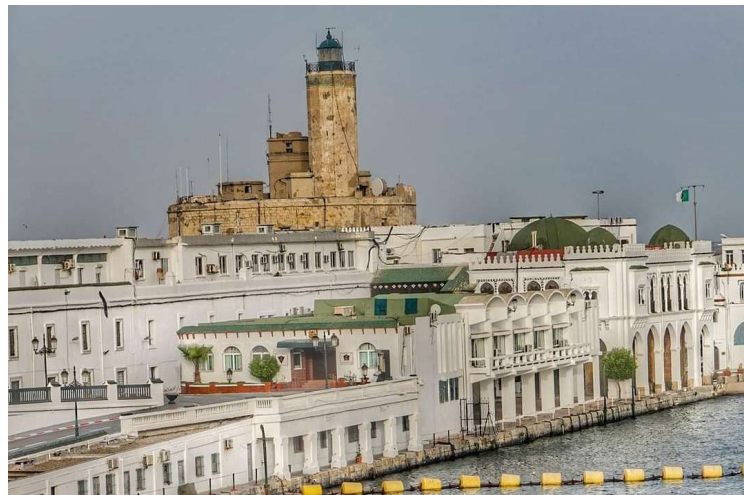
Figure 7.36. Phare de l'Amirauté (Alger). Source : Inconnue.
