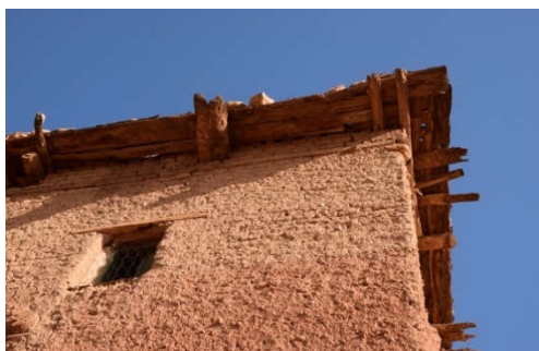
Fig. 6.11: Maison chaoui couronnée par une corniche de 40cm
