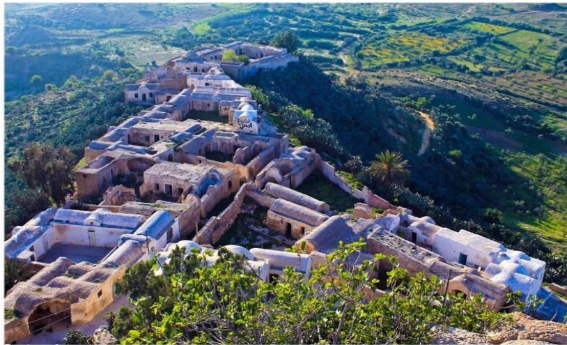
Fig 4.28 : Vue d'ensemble sur le Village Takrouna
