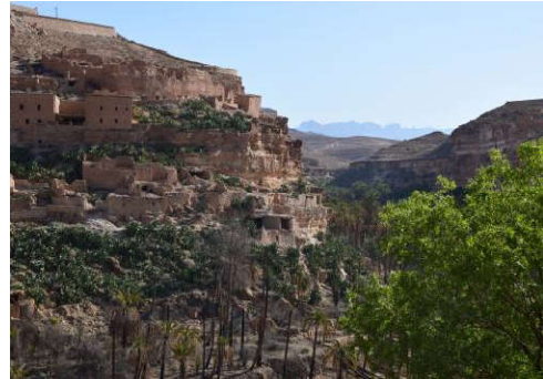
Fig.09: Maisons au village Rhoufi Source : Auteur 2018
