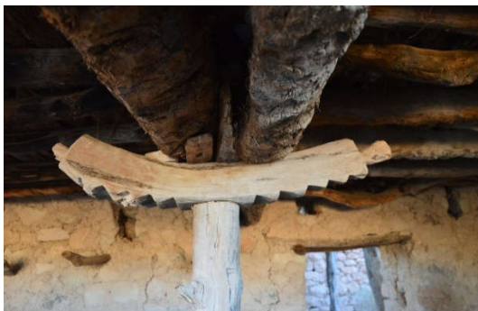
Fig. 6.15: 1er Exemple d'une structure d'une maison Chaoui .
