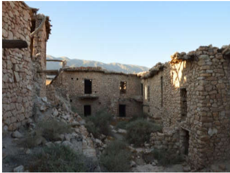
Fig.7.44 : Vue à partir de la cours de la Galâa Ath Mimoune.
