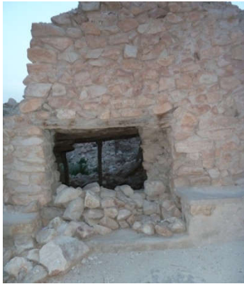
Fig 6.8 : Maison dans les Aurès avec seuil .
