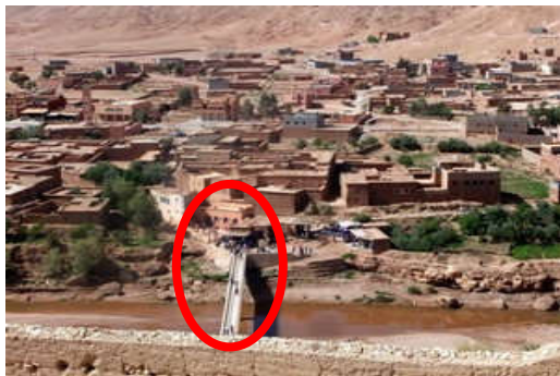
Vue sur le pont après réalisation
