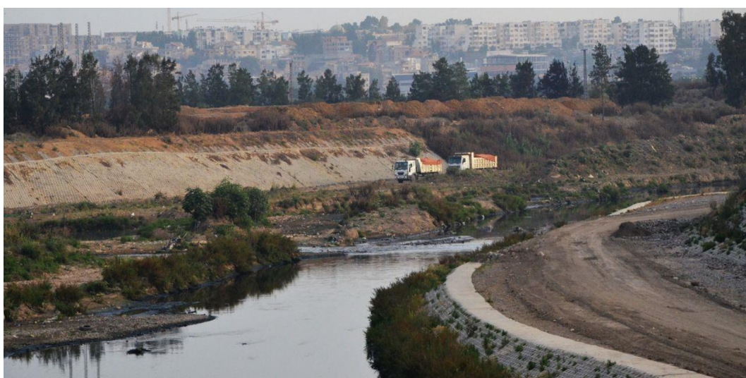
Figure 5. 19 Un aperçu des travaux d'assainissement à Oued el Harrach. Source : Auteur, 2019
