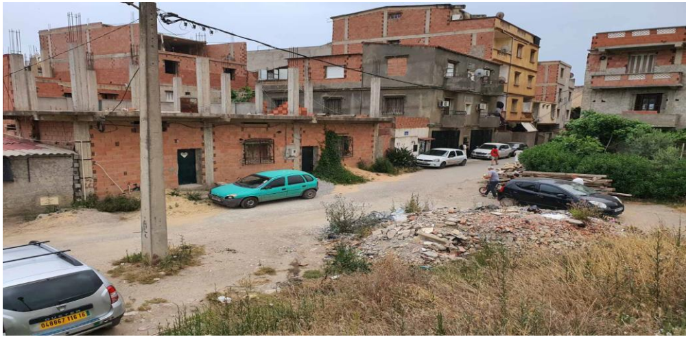
Figure 5. 12 Constructions inachevées dans un environnement dégradé Source : Auteur, 2020
