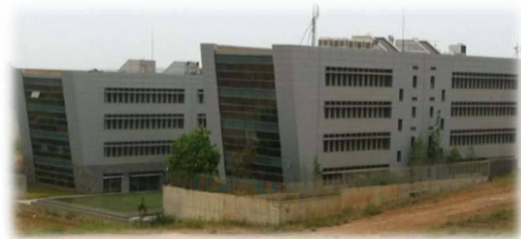
Figure 12 : Environnement extérieur du multilocataire. Source : https://anpt.dz/
