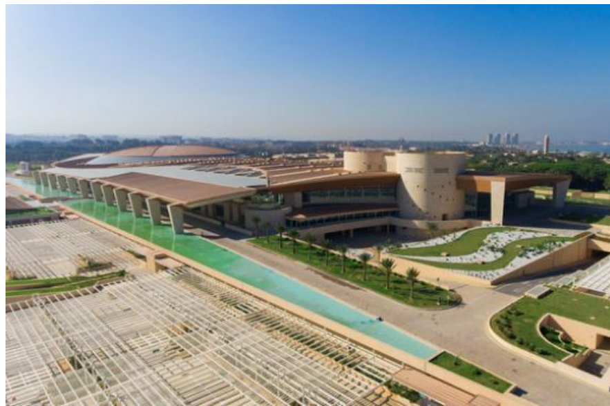
Figure 19 : Vue aérienne du CIC. Source : https://www.architonic.com/fr/project/fabris-partners-cic-centre-international-des-conferences/5104816
