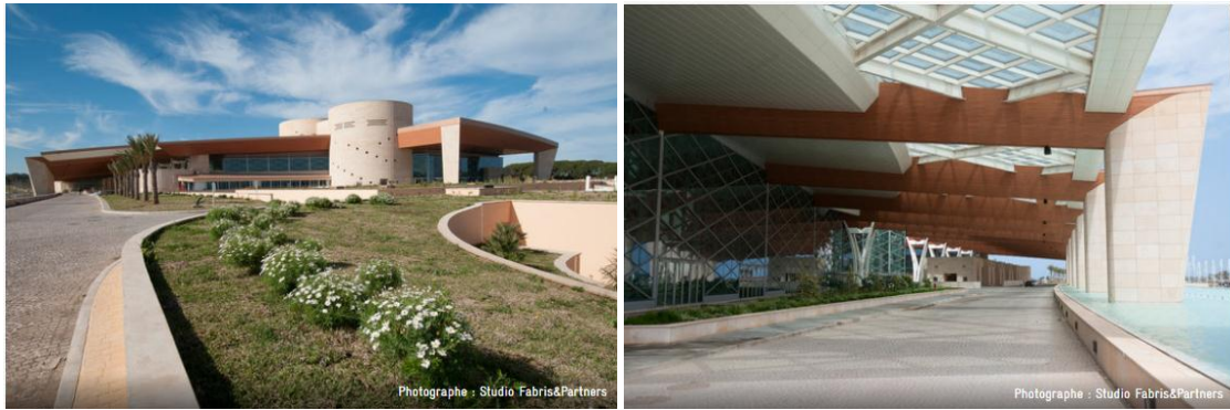
Figure 18 : Environnement extérieur du CIC. Source : https://www.architonic.com/fr/project/fantoni-cic-centre-international-des-conferences-d-alger/5104727
