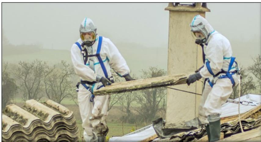
Figure4.04: Désamiantage, enlèvement d'amiante
