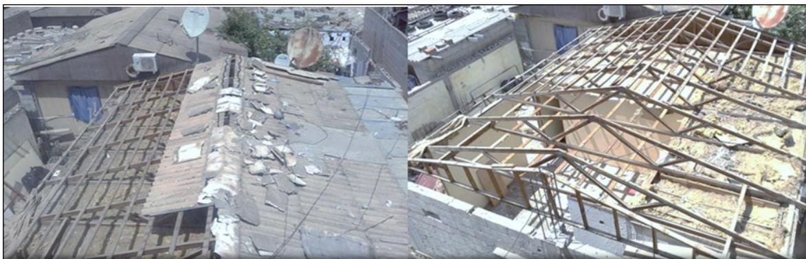
Figure6.2: Retrait de la laine minérale (comble) et plaques d'Eternit (toit)
