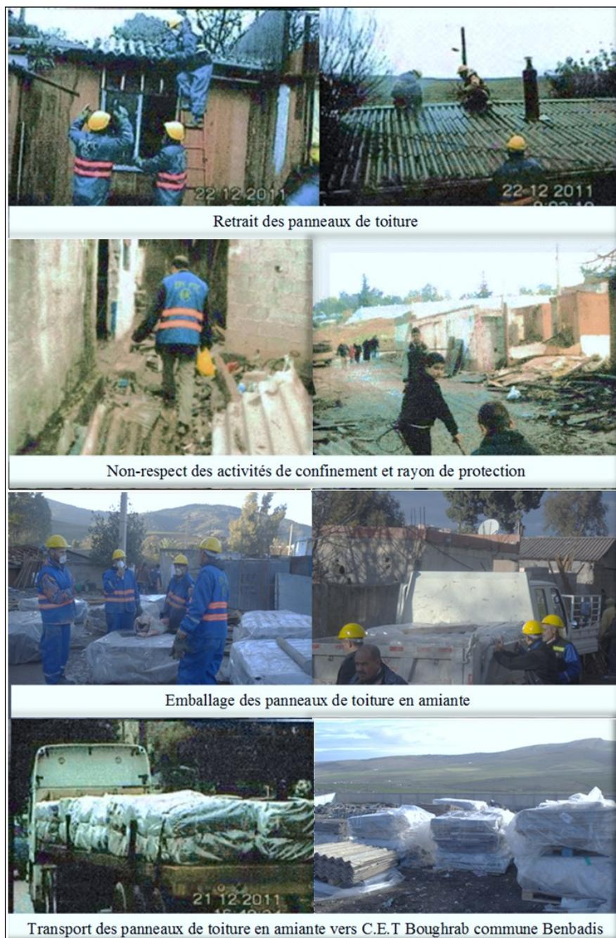
Figure4.12: Opération pilote de désamiantage des chalets Sotraco.
