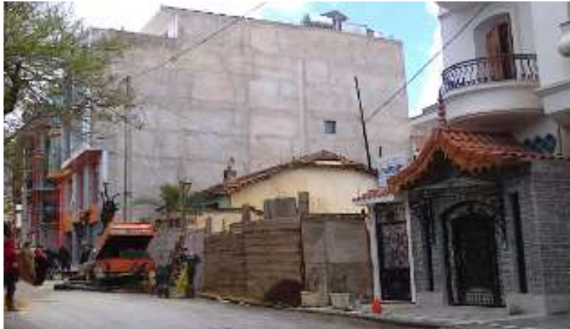
Figure 5.11 Villa avant démolition à sidi mabrouk, chantier en travaux, Source : enquête sur terrain, Bensakhria 2018
