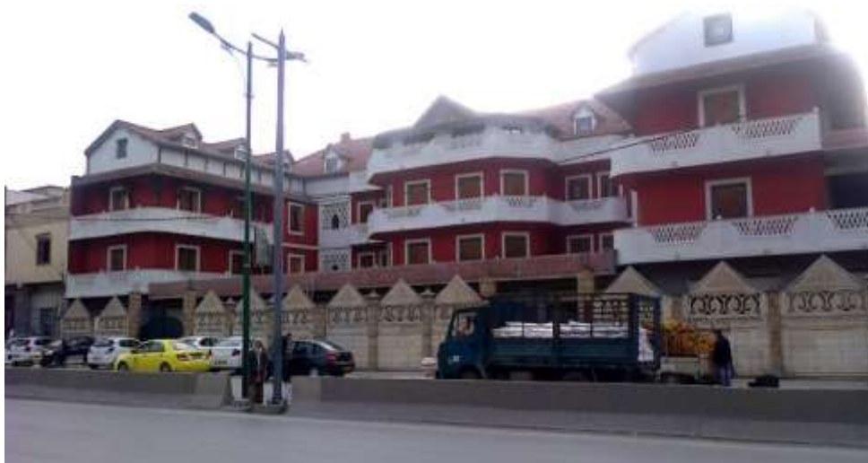
Figure n° 5.35 Habitation luxueuse à l'est de l'autoroute RN3, quartier Onama, Source ; enquête sur terrain, Auteur Bensakhria 2018
