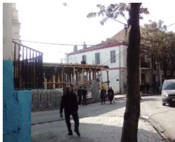
Figure 4.17 : Démolition d'une ancienne bâtisse coloniale et reconstruction d'un Equipement de service Source, Bensakhria 2018
