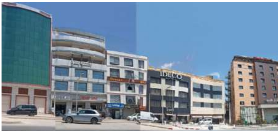
Figure n° 5.48 : Construction de centres commerciaux alignés sur la même rangée à l'Est de la R.N.3, Source, enquête terrain, Bensakhria 2018
