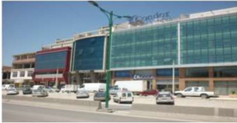
Figure n° 5.33 Façade urbaine sur l'autoroute, quartier Onama Source ; enquête sur terrain, Bensakhria 2018
