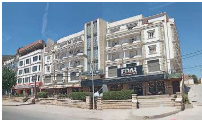
Figure n° 5.47 : Construction avec façade extérieure luxueuse à usage mixte; habitation aux étages supérieurs et commerces au R.D.C, Source, enquête terrain, Bensakhria 2018
