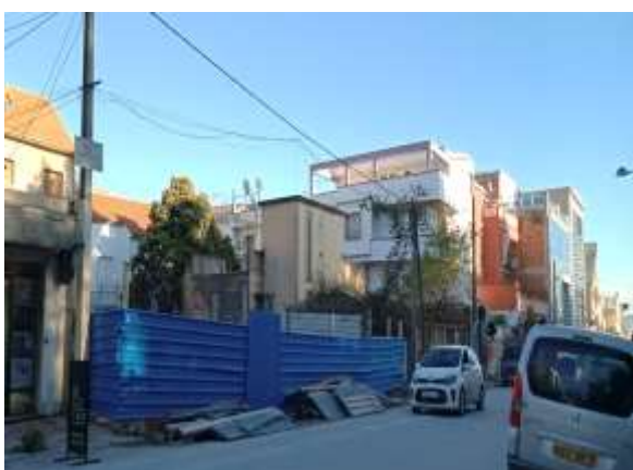
Figure 5.4 : Exemple de démolition d'une maison individuelle perturbant l'aspect du quartier Sidi Mabrouk. Source Bensakhria ; 2020
