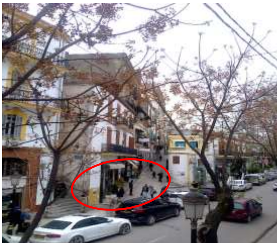
Figure 4.16 Transformation du R.D.C. des logements en Boutiques commerciales, Source, Bensakhria 2020
