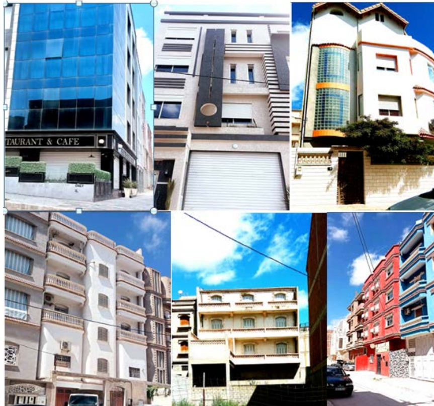
Figure 4. 21 : Absence de lecture homogène de la façade urbaine (Auteur, 2022)
