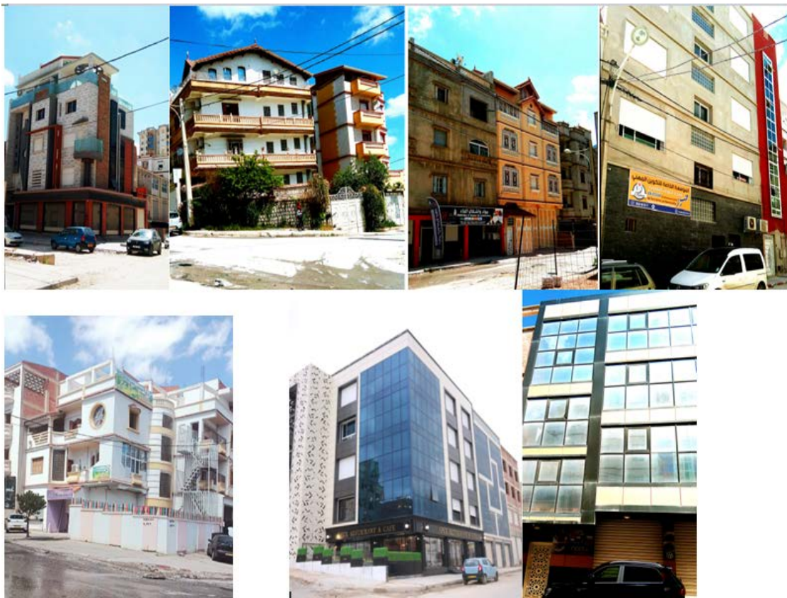
Figure 4. 20 : Dépassement des hauteurs permises et détournement des fonctions (Auteur, 2022)
