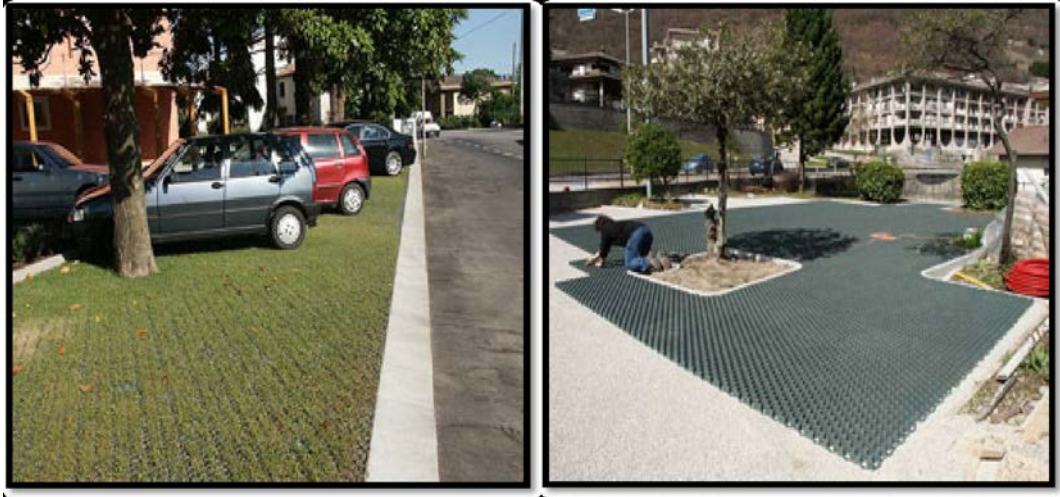
Figure 6. 18 : Stratégies de transformation des revêtements en bitume par des surfaces perméables
