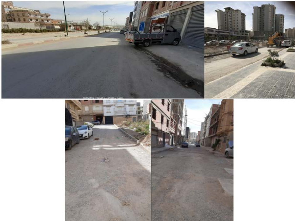
Figure 4. 14 : Typologie et état des voiries (Auteur ,2021)
