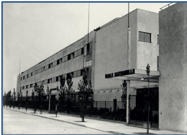
Fig 2.1 : Façade principale du Groupe scolaire Karl Max (bâtiment en verre et en béton) Source : Agence de presse Meurisse. BNF, Paris.
