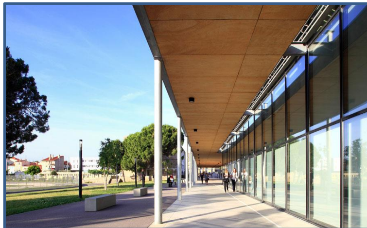
Fig 2.71 : Vue sur le préau du lycée-Jean Lurçat à Perpignan France
