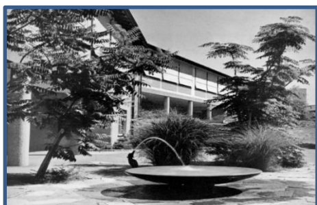
Fig 2.5: Vue sur le préau ouvert au rez-de-chaussée, qui relie le bâtiment au parc
