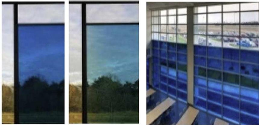
Figure 4 12 Exemple d'un vitrage électrochrome commercialisé (Tällberg, 2019).
