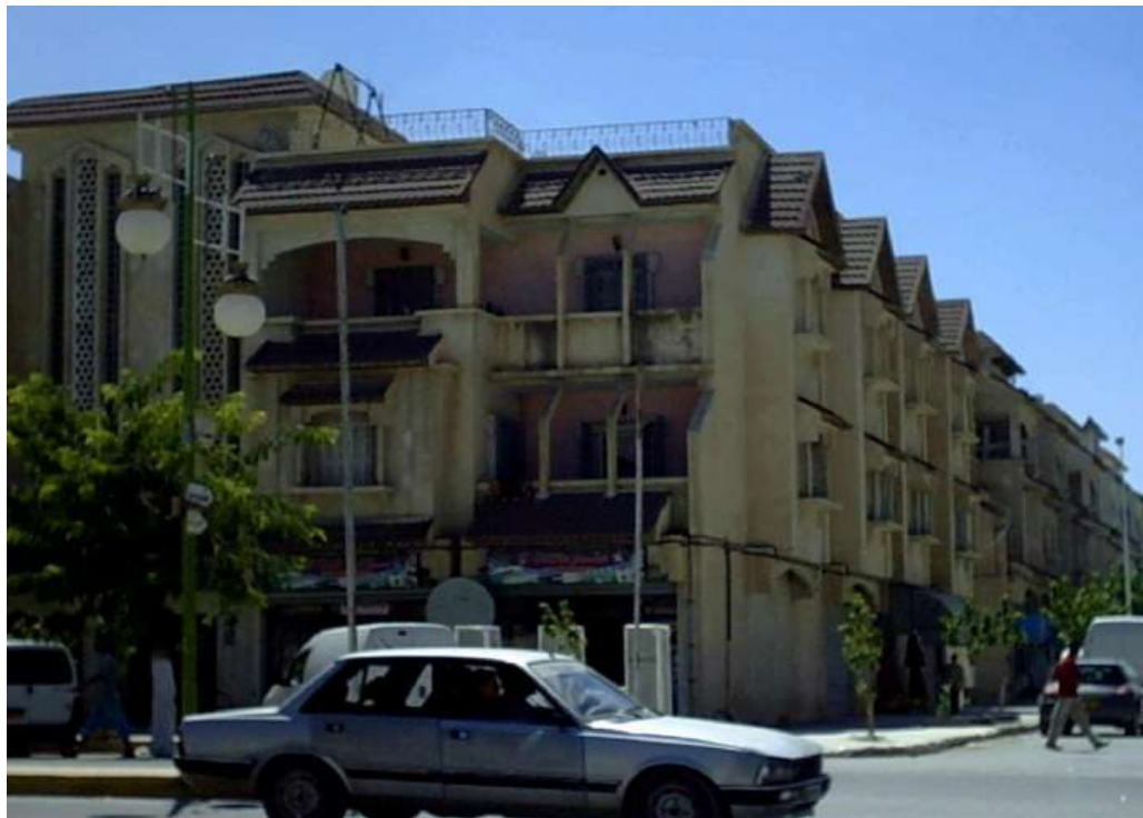
Photo 20 : Partie de 56 villas individuelles (promotion 160 logts) (en face et au fond du cliché) implantées sur la rive gauche de l'avenue "1 er Novembre 1954" et sur la rue secondaire qui lui est perpendiculaire. Commerces aux RDC et résidence aux étages (cliché M. Gherbi, août 2010).
