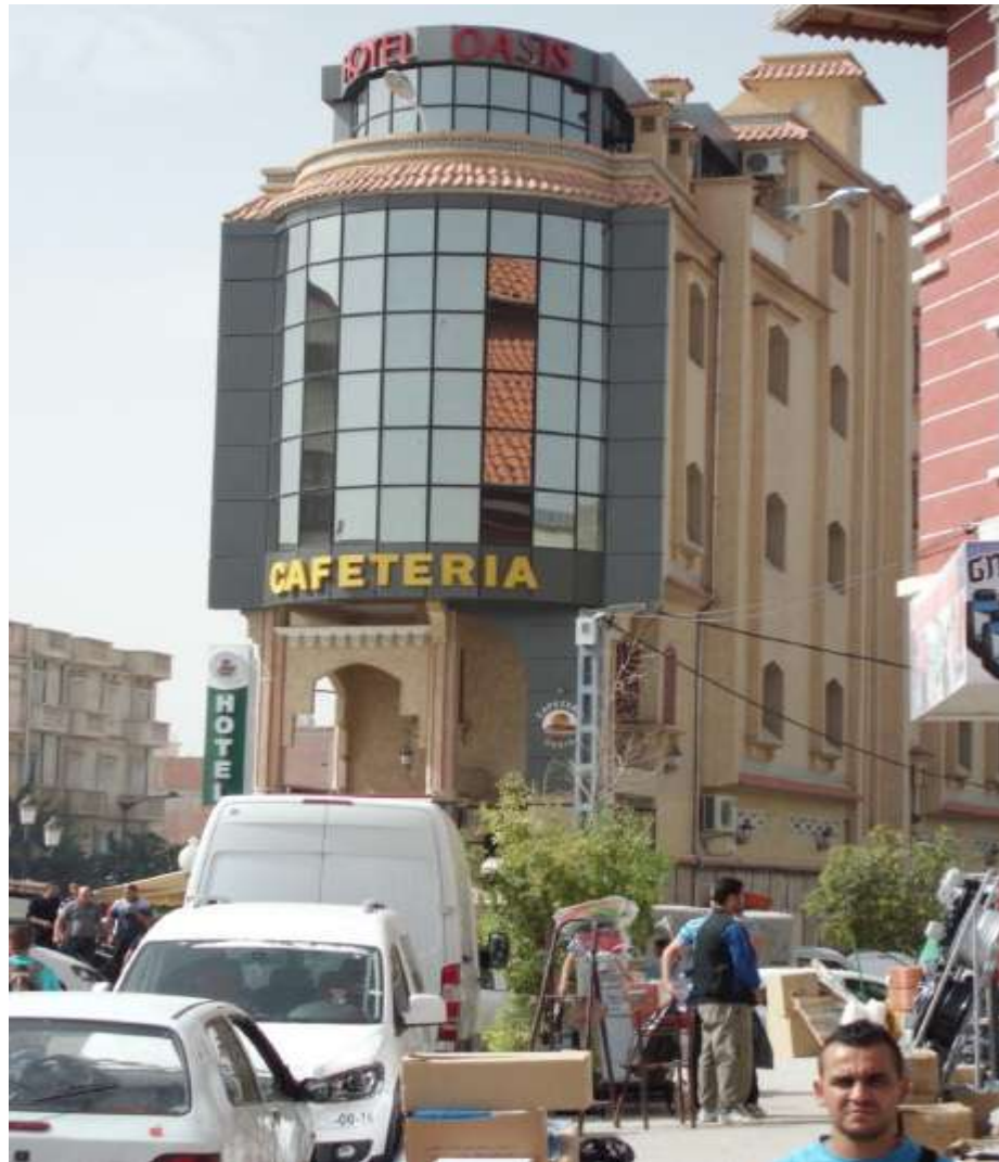
Photo 12 : Hôtel Oasis implanté sur la rive droite de l'avenue "1 er Novembre 1954" avec traitement spécifique de l'angle du bâtiment où en RDC, une cafétéria ouverte sur rue a été réalisée. Ce bâtiment était résidentiel et a été réalisée par l'agence foncière d'El Eulma. Au sol (dans le cliché), les trottoirs sont envahis par les quincailleries (cliché M. Gherbi, octobre 2014).
