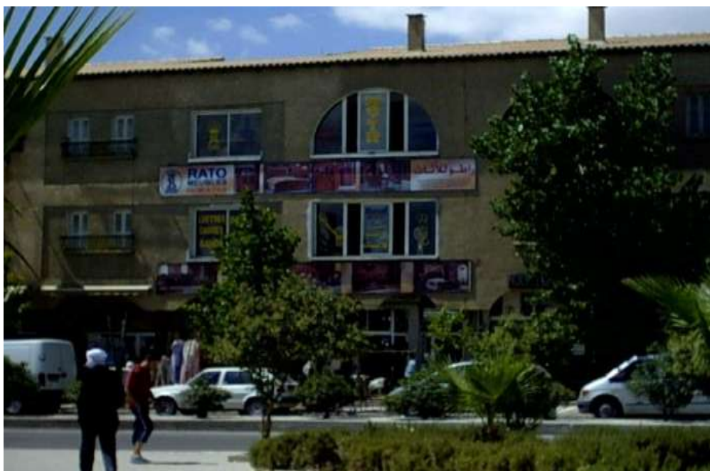
Photo 1 : Partie de l'immeuble "Génie sider" entièrement englouti par le commerce. Les étages supérieurs sont réservés à la vente des meubles (cliché M. Gherbi, août 2011).
