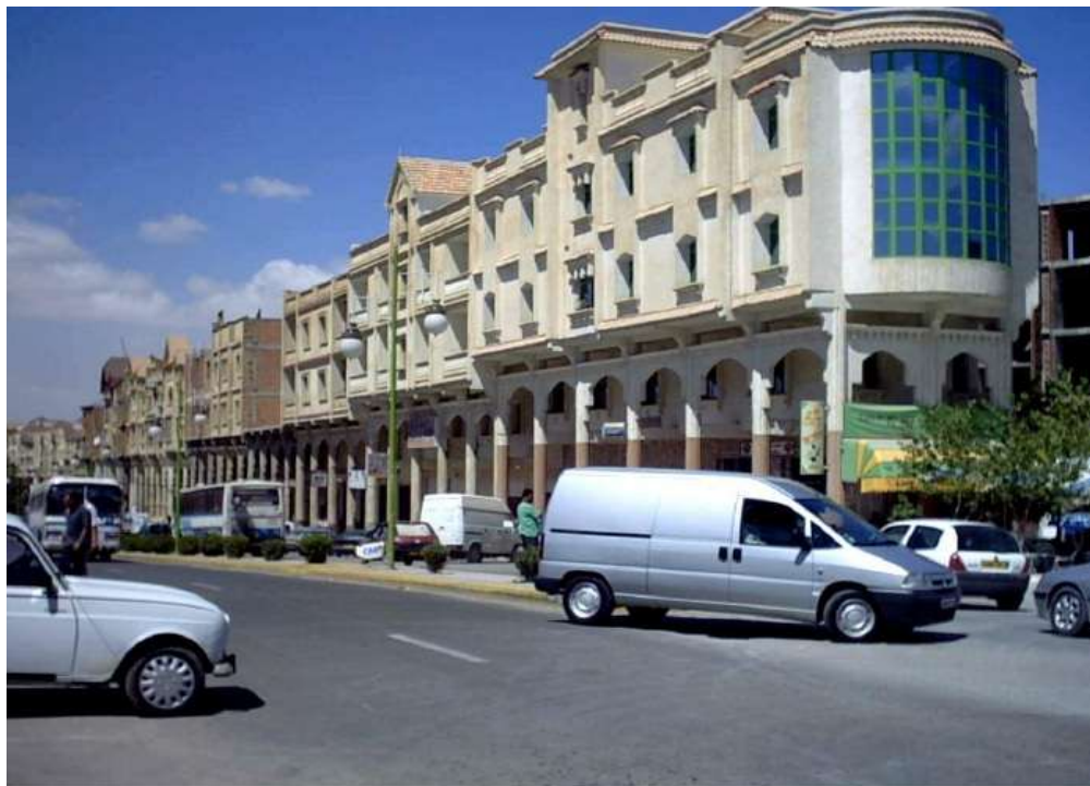
Photo 19 : Continuité urbaine créée sur la rive droite de l'avenue "1 er Novembre 1954" environnant la place "Doubaï" : façade formée de la promotion 64 logts et de coopératives (cliché M. Gherbi, août 2009).
