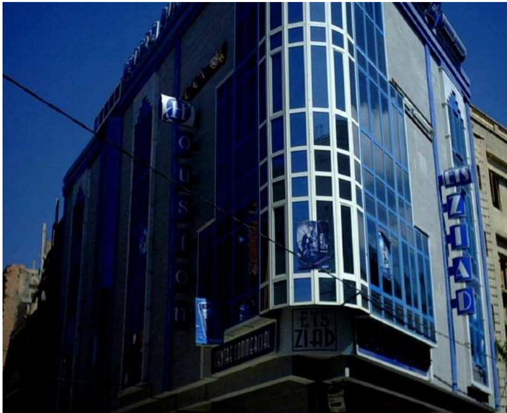
Photo 11 : Centre commercial reconverti en hôtel en octobre 2010 qui a gardé la même architecture de sa façade revêtue en mur rideau et alucobond et traitée en son angle selon un axe de symétrie affirmée (cliché M. Gherbi, août 2006).
