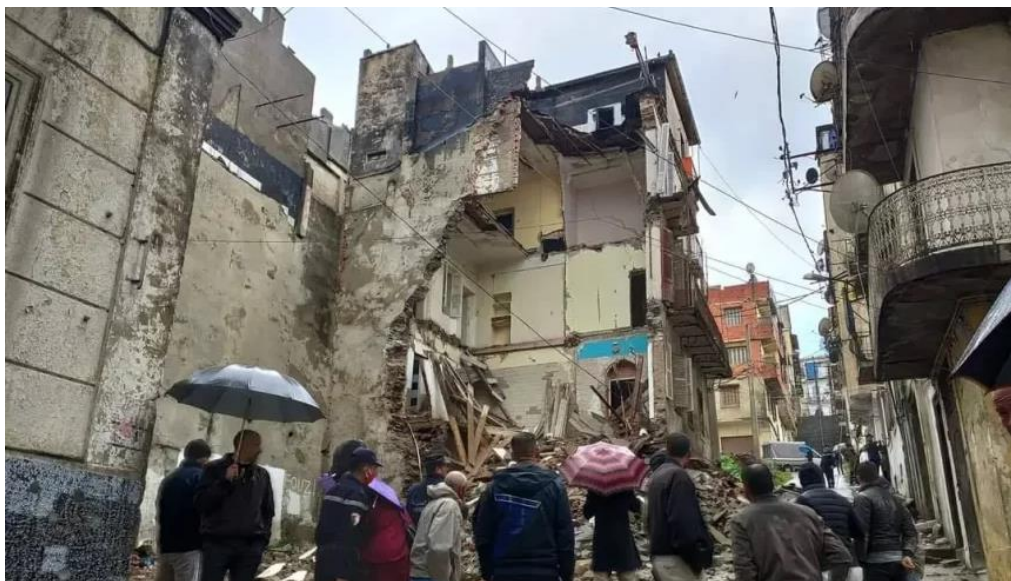
Figure 9- 26 Effondrement d'une partie d'un bâtiment (Partie News, 2023)
