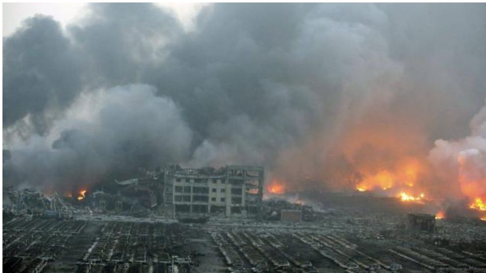
Figure 2- 13 Dégâts d'explosion dans le port de la ville de TIANJIN en Chine (ARIA, 2017)
