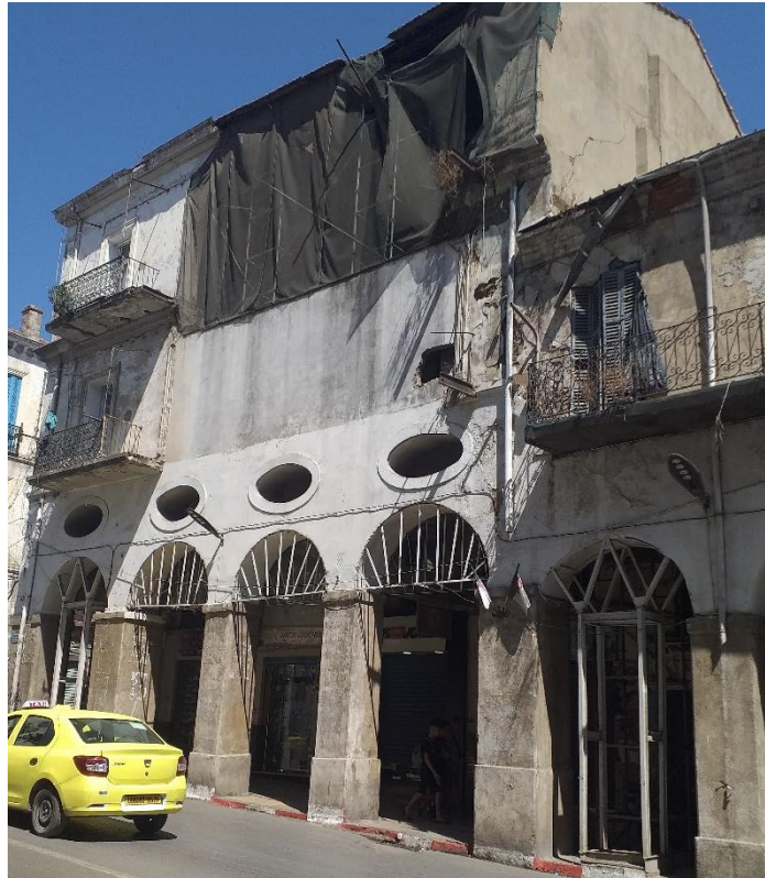
Figure 9- 25 Stabilisation des arcades de Rue Didouche Mourad (l'Auteur 2023)
