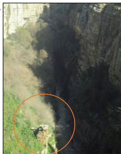
Figure 4.20 : piliers d'un pont romain. Source : auteur (2021)
