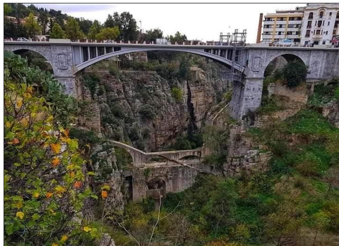
Figure 4.31 : Vue du pont actuellement. Source : web.
