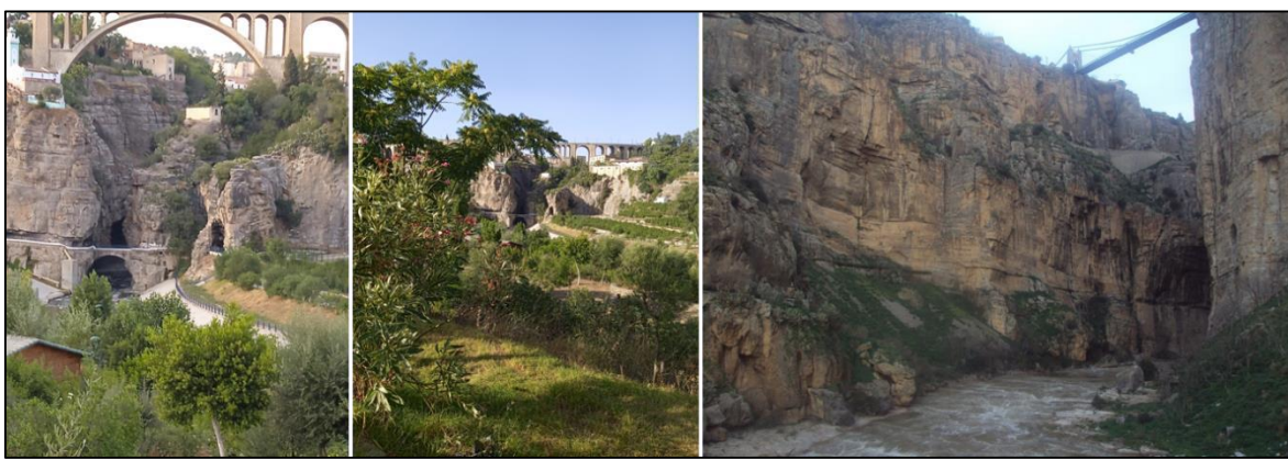
Figure 6.3 : Entrée et sortie des Gorges du Rhumel. Source : Auteur 2021-2023
