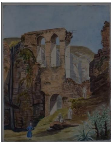
Figure 4.30 : Vue du pont démoli. Source : web.
