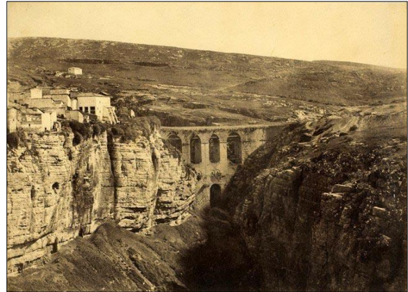
Figure 4.29 : photo du pont restauré. Source : http://www.moma.org .
