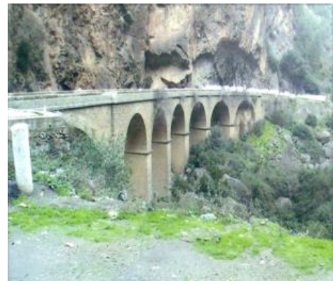
Figure 5.31 : Pont de Chaabet Al Akhra à Kherrata
