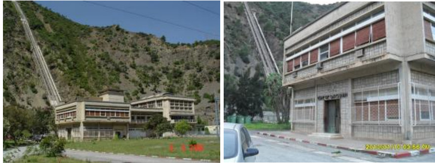
Figure 5.36 : Usine Hydro-électrique de Darguina Source : Agence Sonelgaz de Darguina, 2006 ; 2010.
