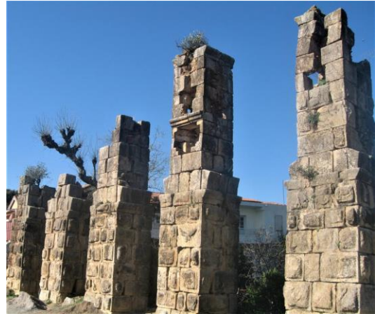
Figure 5.6 : Piliers du pont aqueduc de Toudja
