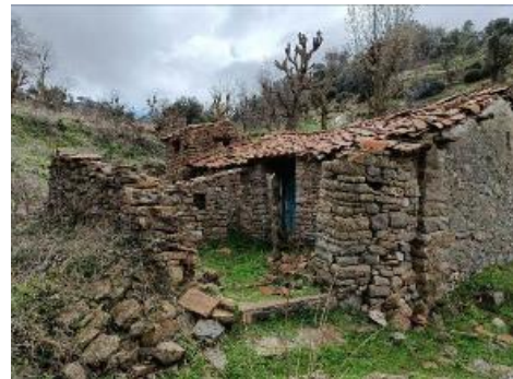
Figure 5.13 : Intérieur du village d'Ibarissen
