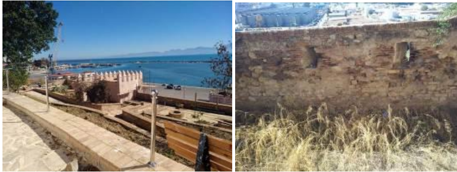
Figure 5.68 : photos de la muraille de la casbah de Bejaia
