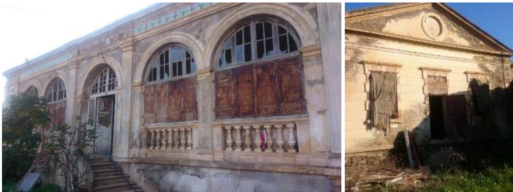
Figure 5.35 : Ferme agricole à Amizour
