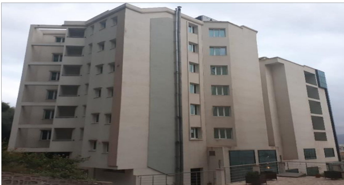
Figure 4.24 : Façade arrière de l'hôtel de Bejaïa.
