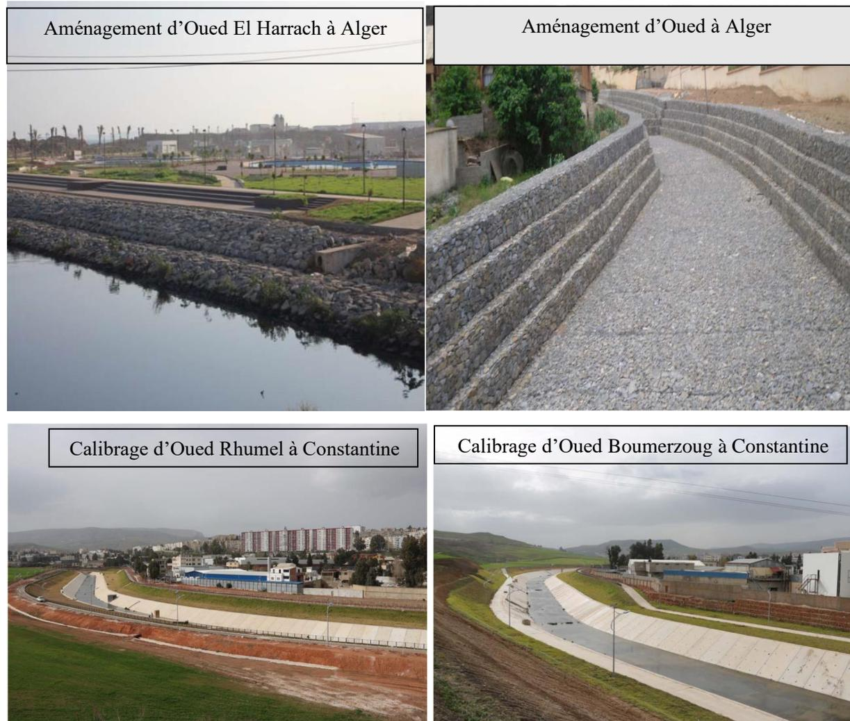
Figure 5.1 Travaux d'aménagement et de calibrage des cours d'eaux menaçants
