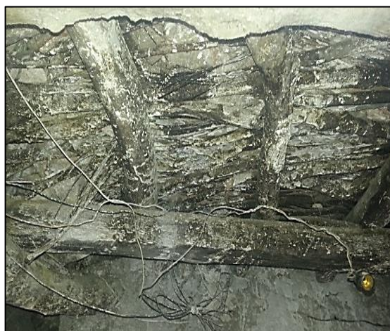
Figure 7. 36 : planchers en rondin Source : auteure, 2023
