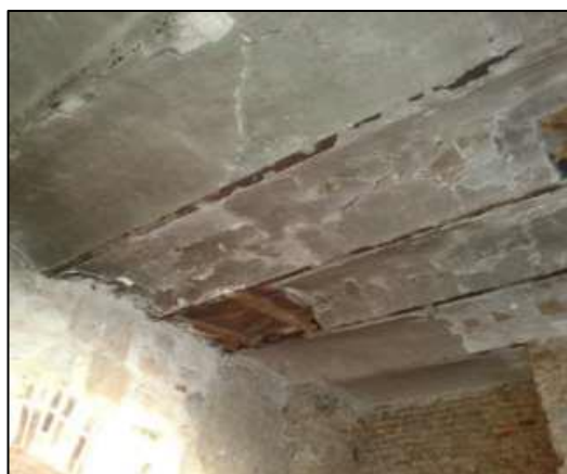
Figure 7. 39: placher en Voutain exemple 1 Source : auteure, 2022
