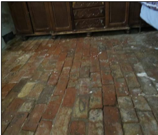
Figure 7. 44: revêtement en brique Source : DCA/Mila
