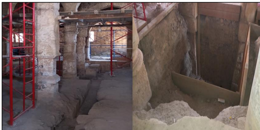
Figure 7. 46 : vues sur les fondations de la mosquée Source : auteure, 2021
