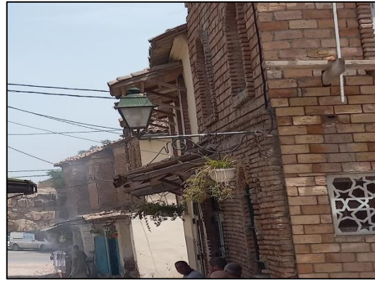
Figure 7. 50 : mur en brique Source : auteure, 2022
