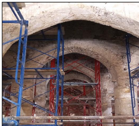
Figure 7. 57: vue sur les arcs extérieures Source : auteure, 2022
