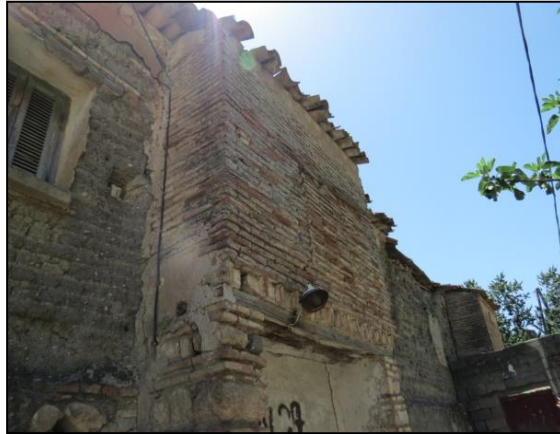
Figure 7. 25: vue sur un encorbellement Source : PPSMVSS
