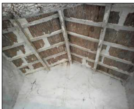
Figure 7. 41: vue intérieure sur la couverture d'une maison Source : Bouhennache T, 2018
