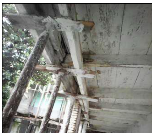
Figure 7. 37: plancher en bois : Source : PPSMVSS
