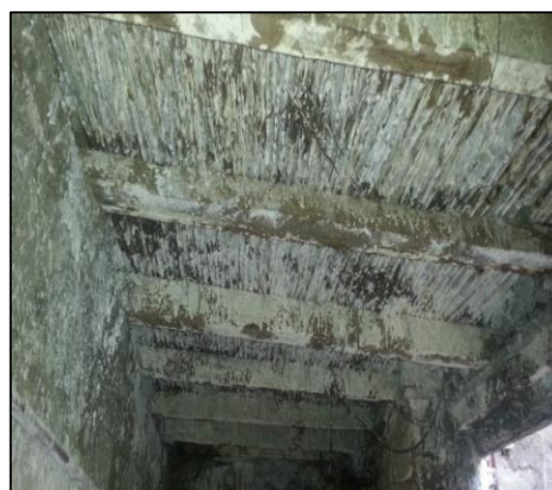
Figure 7. 38: plancher en bois : Source : auteure 2023
