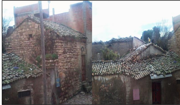
Figure 7. 43: vues sur les toitures des maisons du Vieux Mila Source : auteure, 2022
