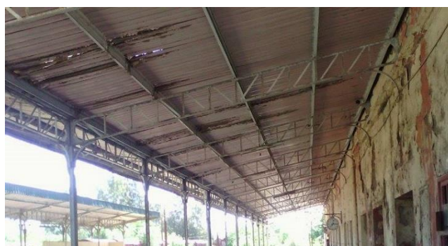
Figure 6.35 : Détail de la structure de l'avent couvrant les quais Source : (Auteur, 2018).
