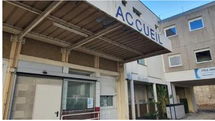
Figure 2.6 : Un ancien bâtiment d'accueil au cœur de la friche hospitalière de l'ex-polyclinique Saint-André, Reims, France.
