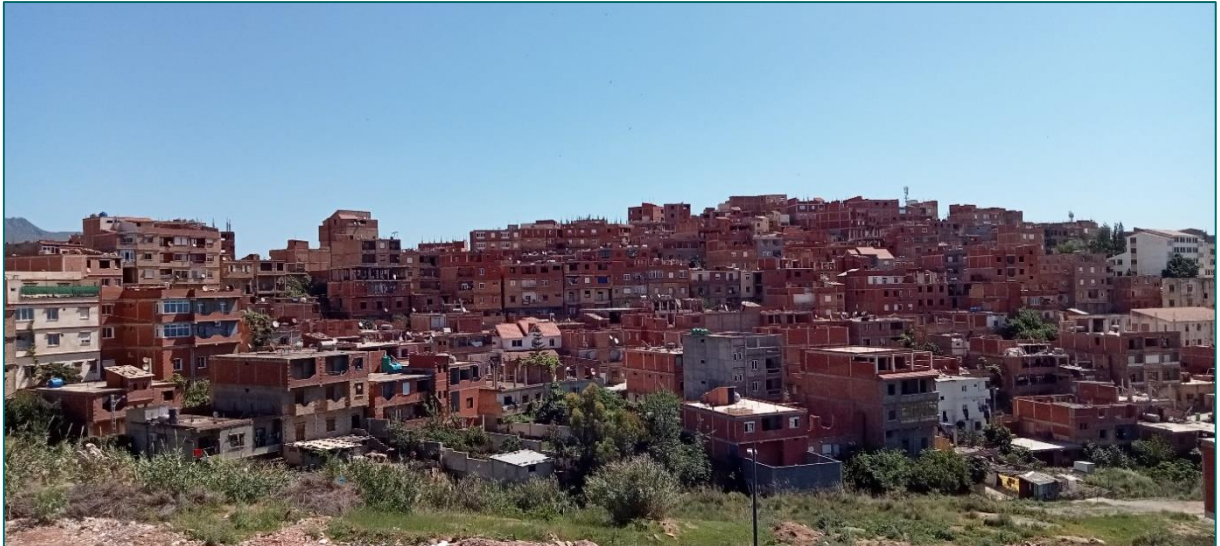
Figure N° 22.06 : Quartiers périphérique : une production urbaine illicite et bâclée
