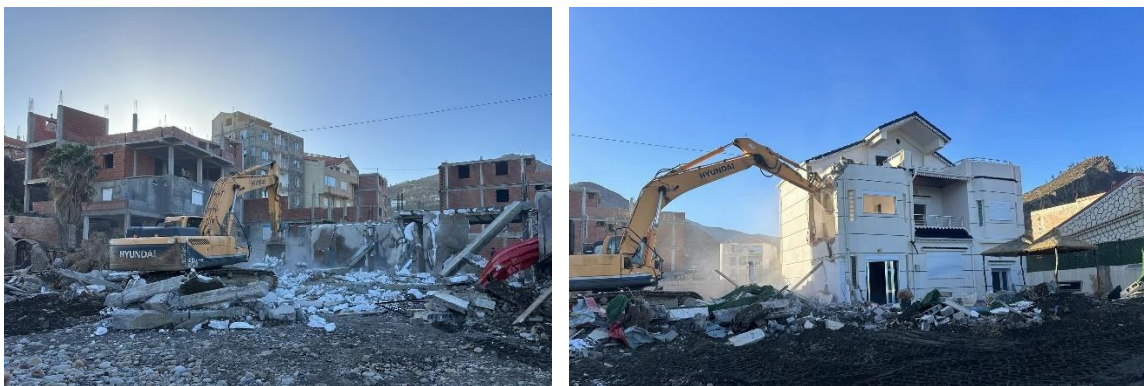
Figure N° 02.05 : Bejaia : Opération de démolition des constructions illicites à Toudja
