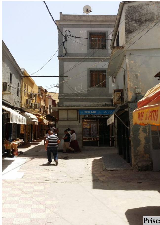
Photos 5: Les transformations architecturales dans le cluster orfèvrerie (Source : Auteur, 2017).
