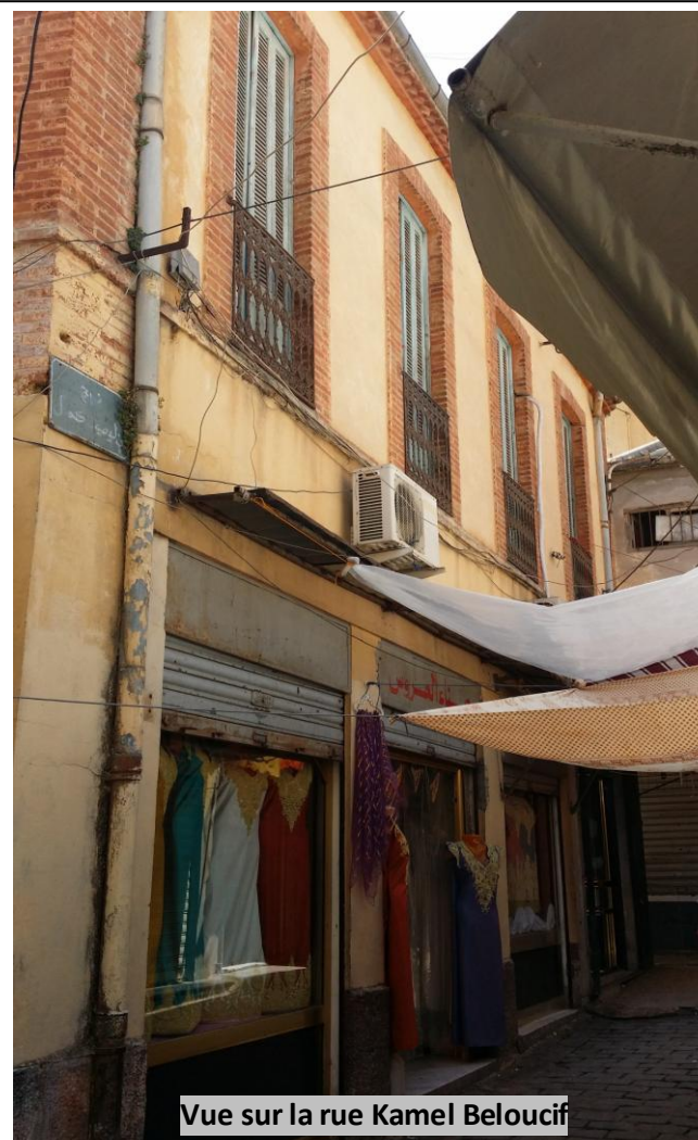
Des opérations de réhabilitation et de maintenance sont visibles dans le cluster commerce habit traditionnel.
