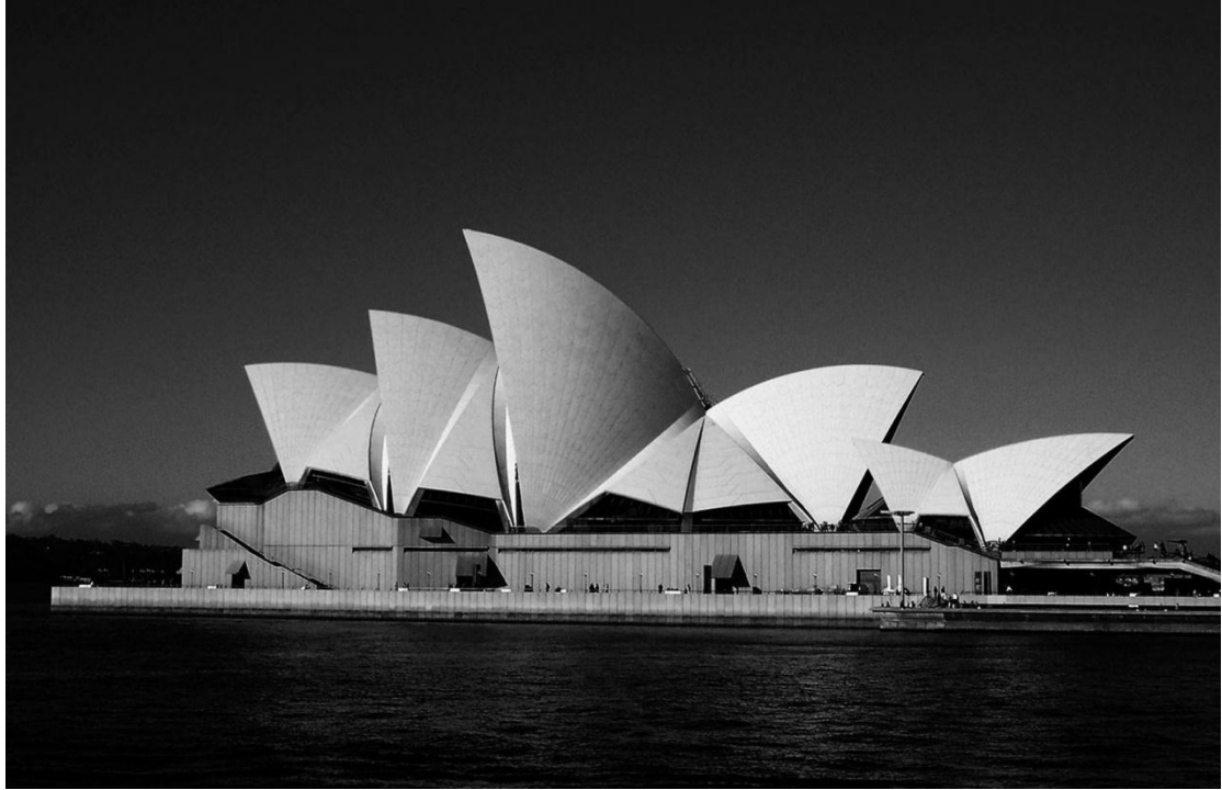
Fig. N°67. Opéra de Sydney Vue « latérale ».
