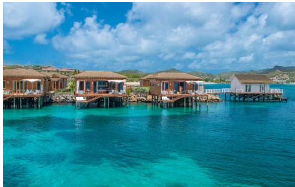
Fig N°46. Constructions sur pilotis.
