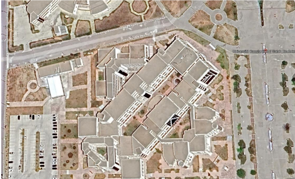
Figure 3.8 Photo aérienne de la faculté de Science de l'information et de la communication et de l'audio-visuel. Source : Google earth, février 2024.
