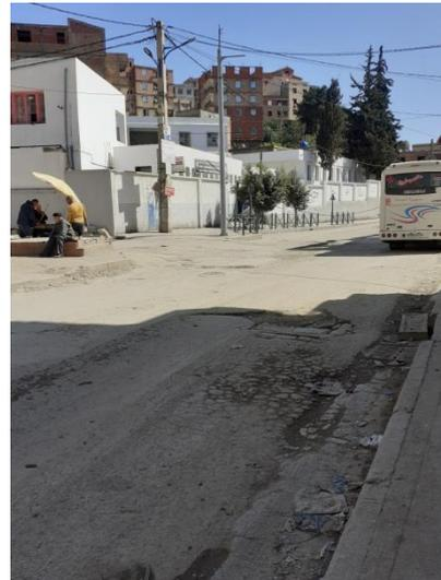
**Figure 0.4:** La dégradation de la chaussée sur la route de Taghzout
