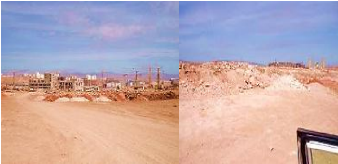
3.14 Chantier de l'UV02 (Les premiers logements LSP et prommotionnel)
