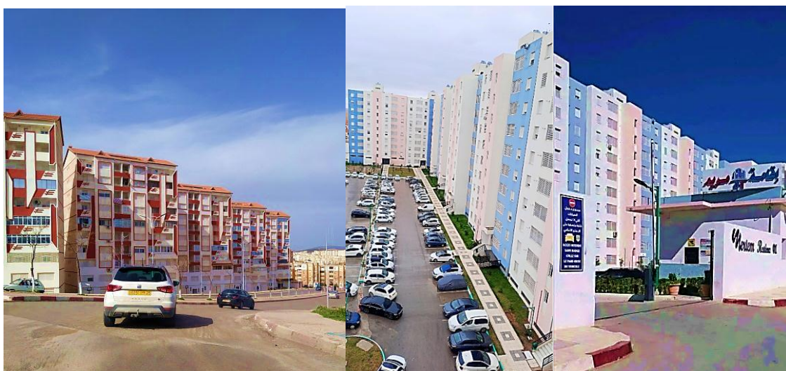
3.18 Exemples de résidences (haut standing), réalisées à la ville nouvelle Ali Mendjeli
