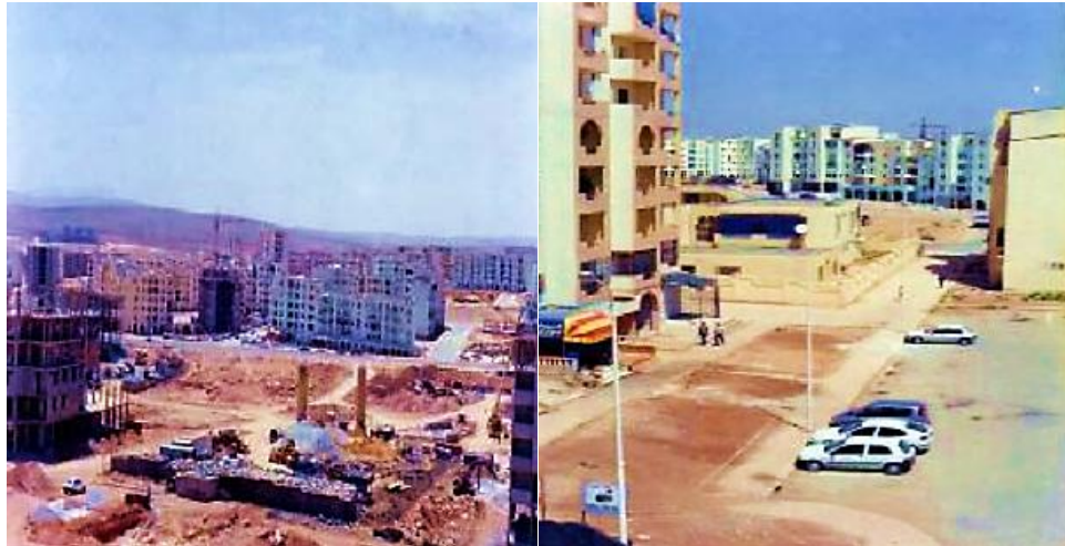
3.12 Chantier UV6 en 1993
