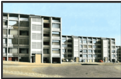
Figure 5.23: Les bâtiments de selis.
