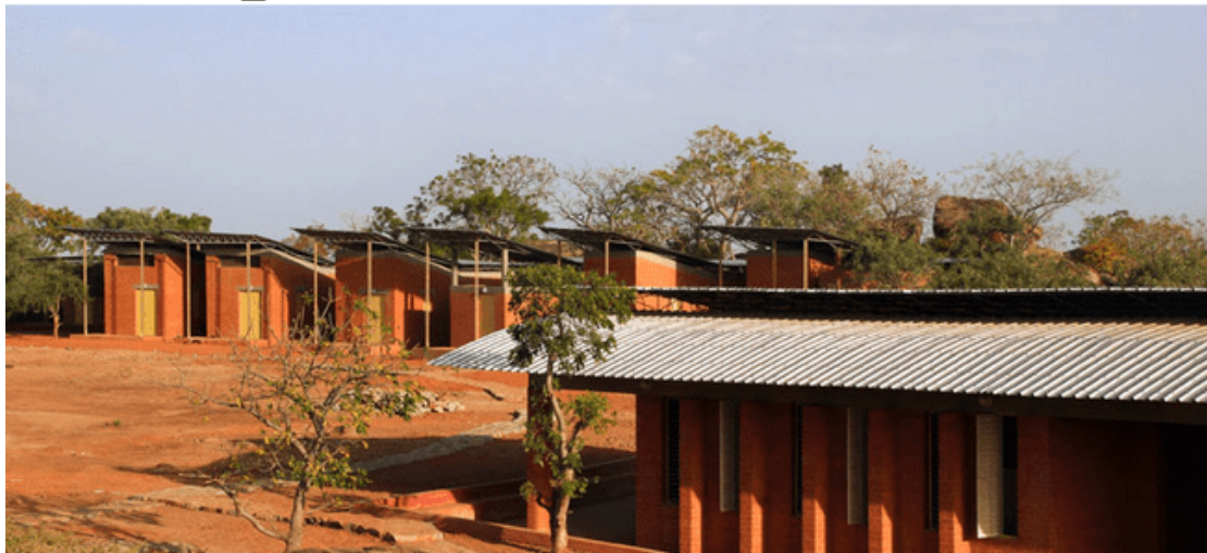
Figure 3.23 : vue sur le projet.
