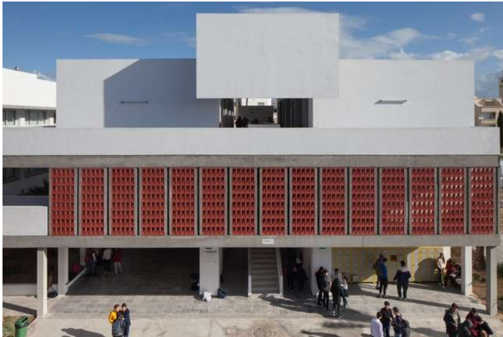
Figure 3.22 : façade du projet de campus.
