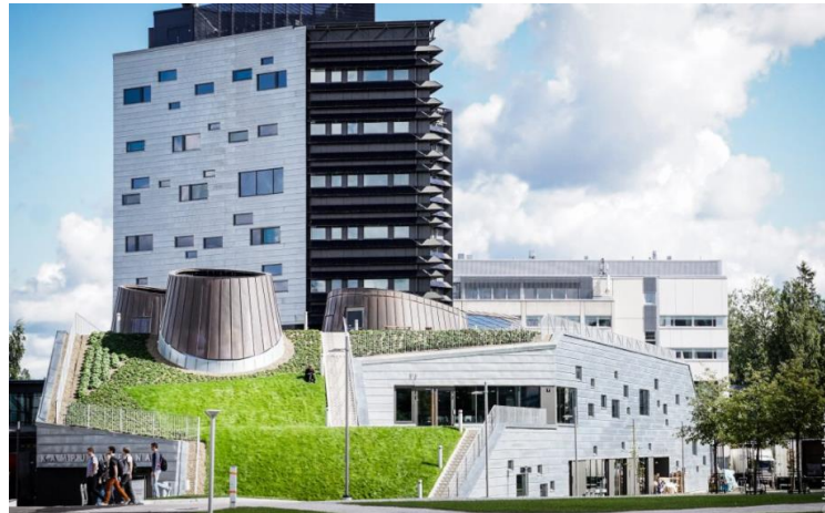
Figure 5.3 : Le bâtiment Kampusareena en Finlande certifié « BREEAM Very good »
