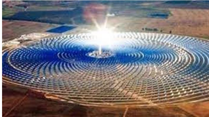
Figure 2.5 : Centrale solaire thermodynamique Noor à Ouarzazate –Maroc.
