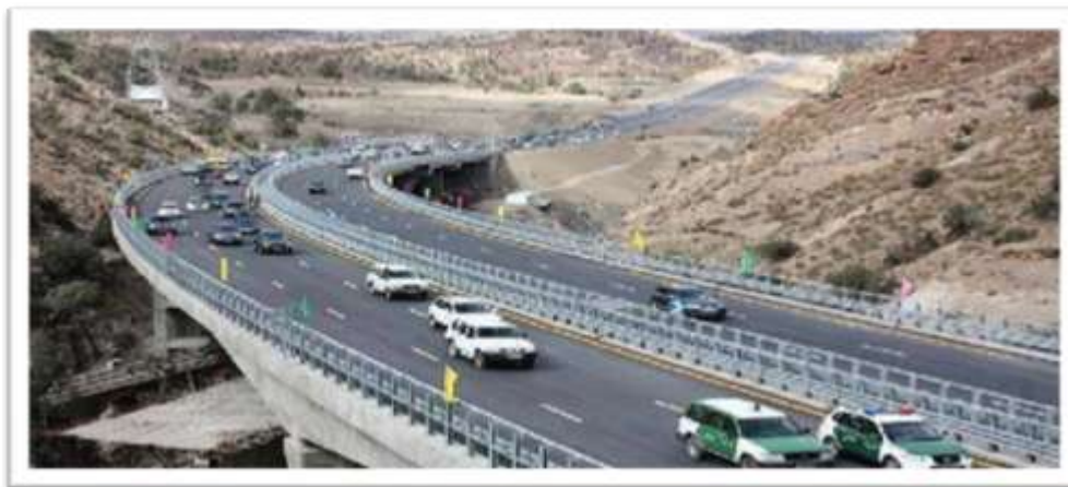
Photo N°19 : Axe autoroutier Est / Ouest
