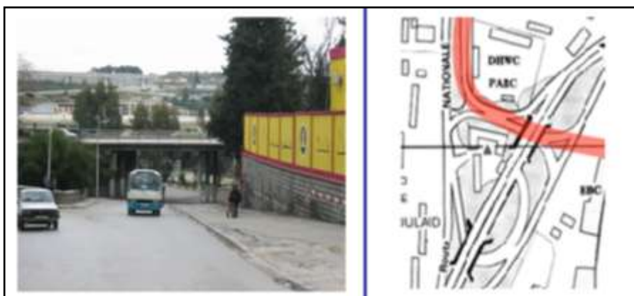
Figure N°55 : L'ouvrage d'Art de Palma
