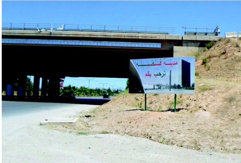
Photographie n° 12 : Panneau à l'entrée sud de la ville
