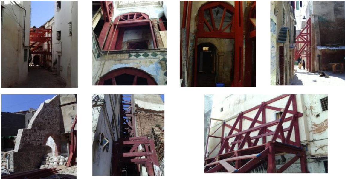
Figure.6.2. Illustration des travaux d'étayement provisoire et de stabilisation des bâtiments, les mesures d'urgence de la phase I.
