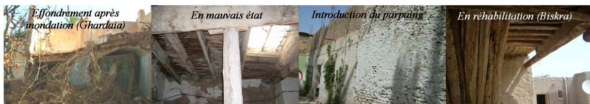
Figure I-5 : Etat des maisons en terre en Algérie
