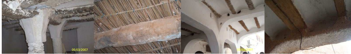
Figure I-4 : Utilisation du palmier (tronc et feuilles) dans la construction à Ghardaia
