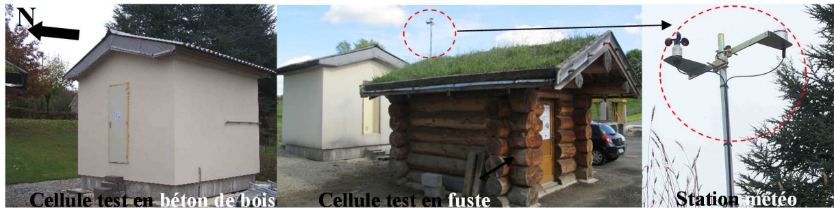
Figure VI-1 : Cellules-test béton de bois et fuste dans leur environnement
