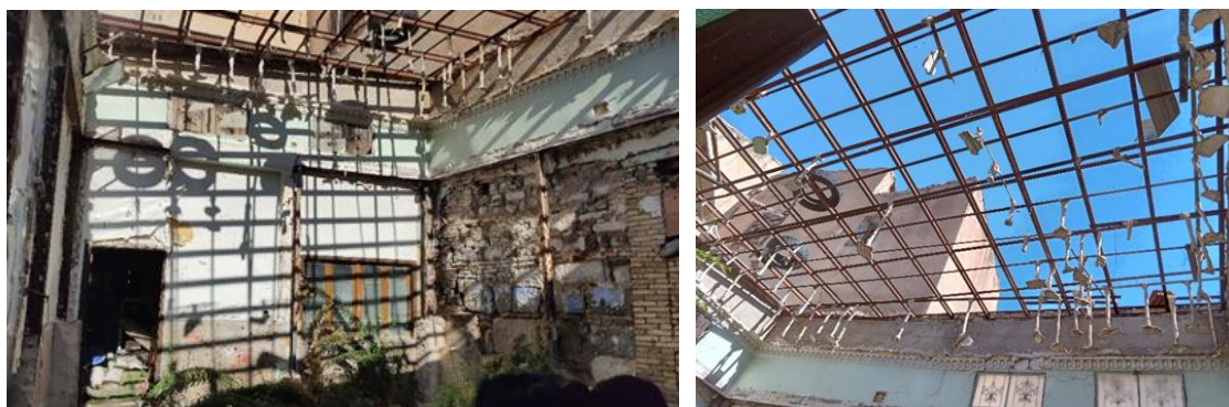
Figure 6.26. Dégradation avancée des murs et de l'ossature métallique. Source: Auteure, 04.2022
