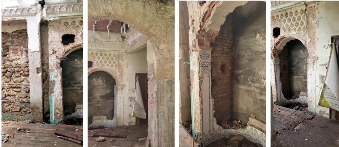
Figure 7.7. Discontinuités structurelles dans les zones de jonction. Source : Auteure, 03.2023
