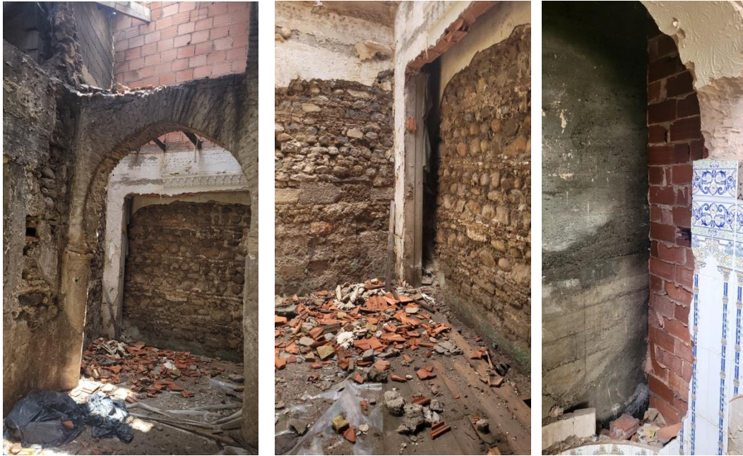
Figure 7.5. Répartition de l'humidité et remontée capillaire sur les murs de la mosquée. Source : Auteure, 03.2023
