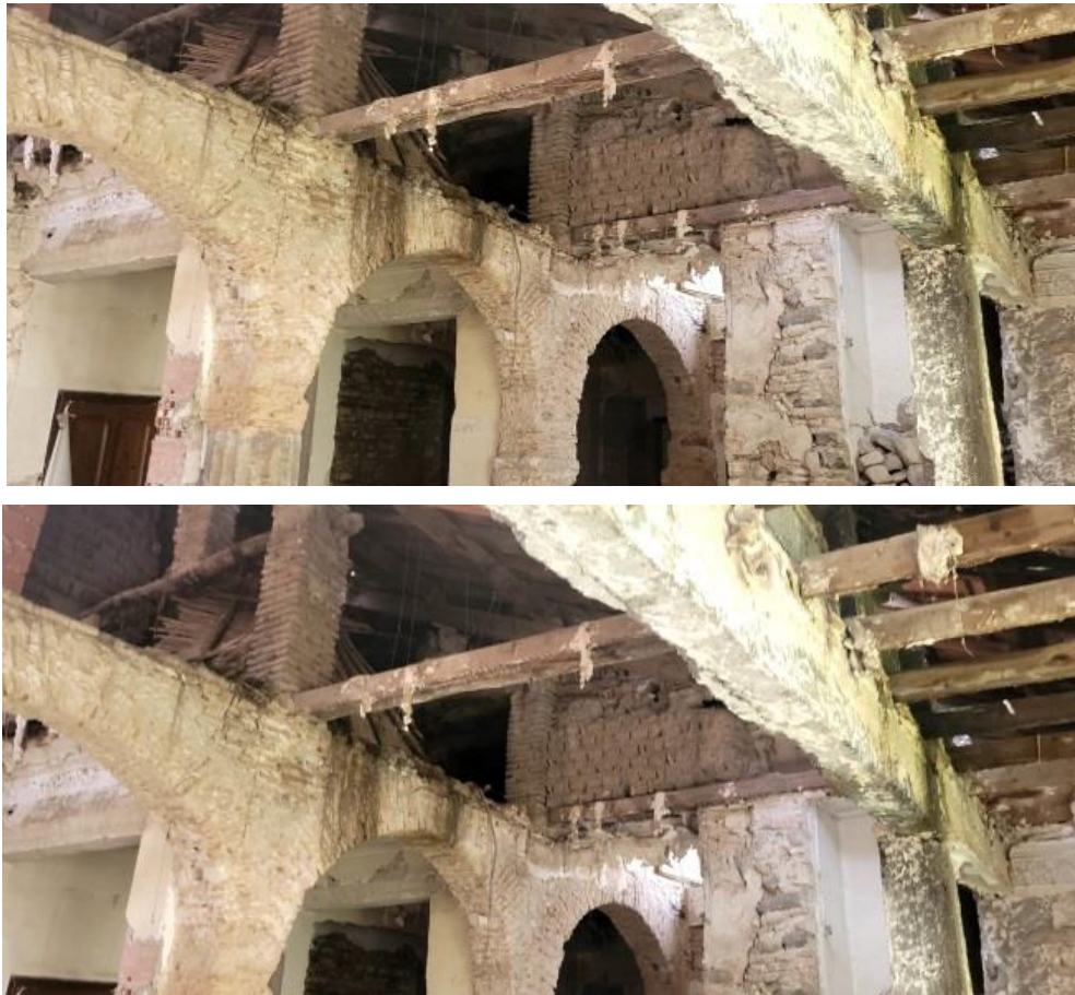
Figure 6.22. Etat de dégradation de la toiture. Source: Auteure, 04.2022
