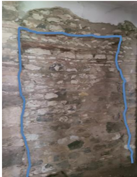
Figure 7.15. Disposition de l'axe du mihrab par rapport à l'axe du dôme et les traces de l'ancien mihrab.
