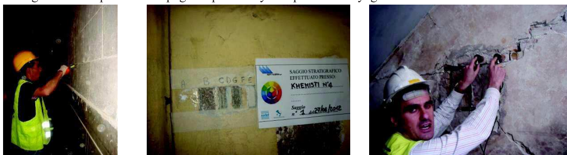
Nétoyage du mur des impuretés
