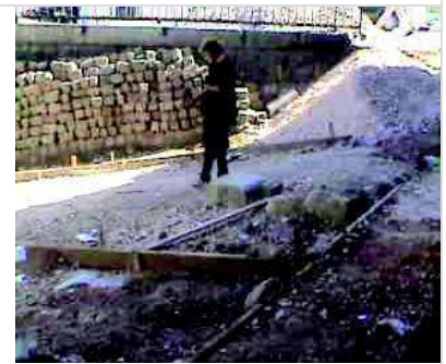
Opération de nivellement de la place Bab El Djabia.
