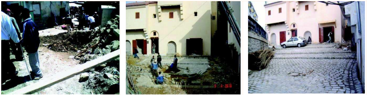
Photos : les phases de la réhabilitation de la place Bab El Djabia en photos. Source : auteur 2010
