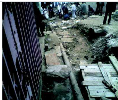
Travaux de remise à l'état de ses assainissements
