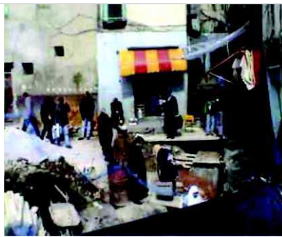
Place Bab El Djabia en chantier
