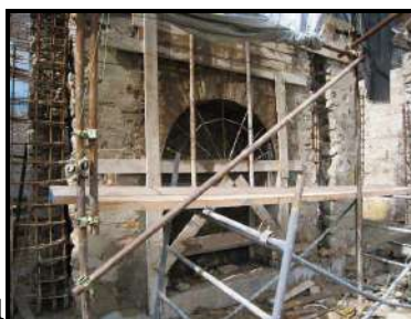
Photo 111 : Mur intérieurs et cloisons en brique posées sur la joue, Mise en évidence de structure en brique terre crue. Photo 112 : Réalisation d'arc en brique pleine (maqqad maison 12) . Photo 113 : réalisation des murs d'encorbellement en briques pleines.
