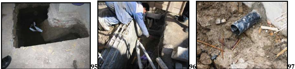
Photo 95: mise en évidence de l'eau au niveau des fondations (maison 19). Photo 96 : Tranchée pour . réalisation du libage : présence d'eau. Photo 97 : Les traverses métalliques. Photo 126 : tubes en PVC \Phi 110 Vue sur le haut du plancher avant coulage de la dalle.
