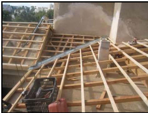
Figure 117 : Détails du système de couverture en pente proposé. Photo 128 : Charpente en bois pour la toiture en pente. Bloc maison 12. Photo 129 : Couverture en tuile canal, maison 12. Novembre 2009.
