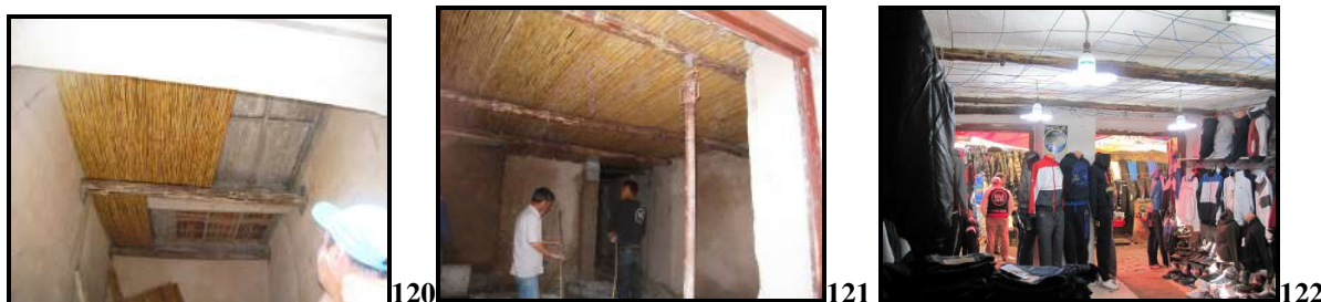
Photo 120, 121 : Plafonds des boutiques en roseau et araar. Photos prises en Mars 2010. Photo 122 : plafon de la boutique sous la maison 19 bis. 8 janvier 2014.
