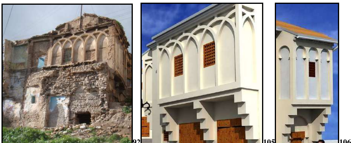
Photo 92 : Arcatures entrelacées maison 52 Mellah Slimane. Figure 105: Arcatures entrelacées proposées pour la maison 19 bis. Figure 106 : Arcatures simples maison la maison 19 bis.
