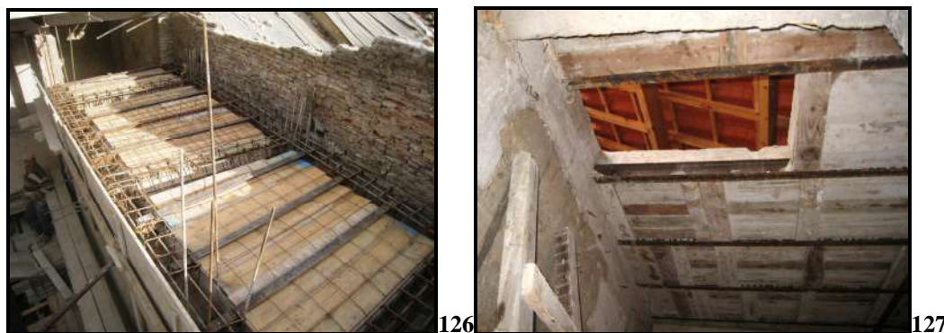
Photo 126 : Vue sur le haut du plancher avant coulage de la dalle. Photo 127 : Vue sur la face inférieure de la dalle sous toit. 2 Nov 2009.
