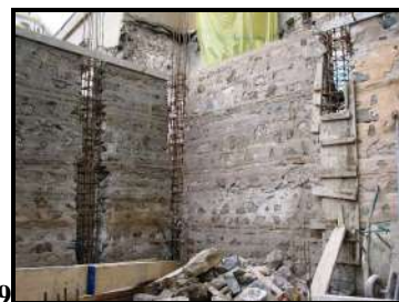
Photo 108 : Mur mitoyen maisons 19 et 19 bis, Mise en évidence de structure en brique terre crue. Photo 109 : rempiètement des murs en maçonnerie à l'originale banchée ( coffrage amovible, destiné à la construction des murs). Photo 110 : Système de maçonnerie chaînée pour la sécurité sismique.
