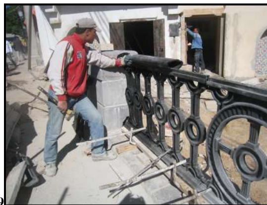
Photo 149 : Mise en évidence du tronçon à reprendre du Pont Sidi Rached. Photo 150 : Reprise à l'identique de la main courante.
