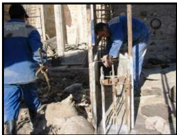
Photo 108 : Mur mitoyen maisons 19 et 19 bis, Mise en évidence de structure en brique terre crue. Photo 109 : rempiètement des murs en maçonnerie à l'originale banchée ( coffrage amovible, destiné à la construction des murs). Photo 110 : Système de maçonnerie chaînée pour la sécurité sismique.
