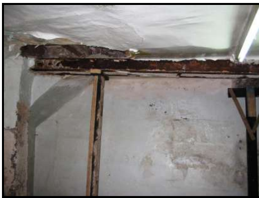
Photo 164 : Etalement des poutres métalliques sur chandelles. Photo 165: Etalement des structures horizontales et plafond avec batterie de chandelles. Maison 19.
