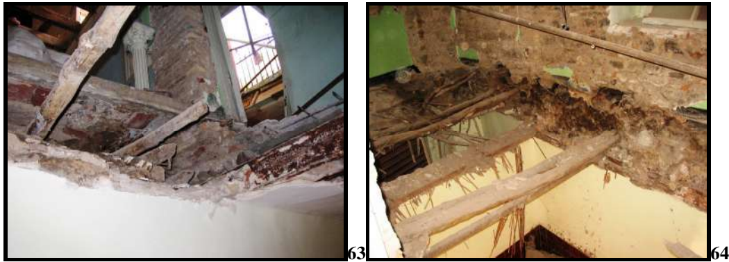
Photo 63, 64 : Planchers de typologie traditionnelle. 1 er étage de la maison 19. Photos de l'auteur. 28/02/2008.
