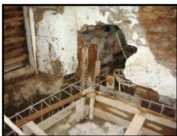
Photo 100: Encadrement par un chaînage en BA, RDC maison 19. Photos 101 : Absence d'appui des piliers. Maison 19 bis. Photo 102 : Libage périphérique extérieur en BA. Bloc Maison 19.
