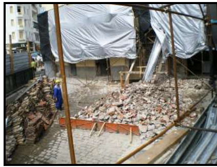
Photo 171 : Evacuation des déblais par goulotte. Photo 172 : Panneau de présentation du projet etc.
