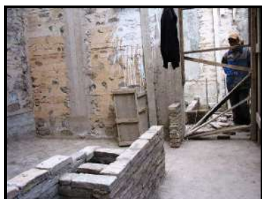
Photo 111 : Mur intérieurs et cloisons en brique posées sur la joue, Mise en évidence de structure en brique terre crue. Photo 112 : Réalisation d'arc en brique pleine (maqqad maison 12) . Photo 113 : réalisation des murs d'encorbellement en briques pleines.
