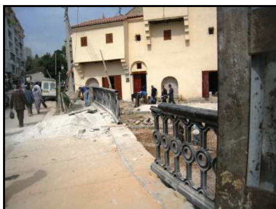
Photo 149 : Mise en évidence du tronçon à reprendre du Pont Sidi Rached. Photo 150 : Reprise à l'identique de la main courante.
