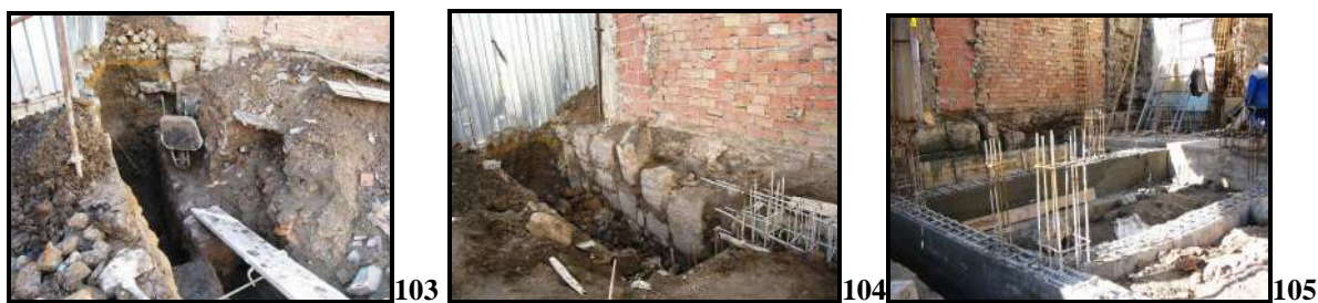
Photo 103: tranchée pour rechercher les fondations d'origine. Maison 12. Photos 104 Récupération des fondations en pierre de taille. Maison 12. Photo 105: Renforcement par une reprise en sous œuvre de BA Bloc Maison 12.
