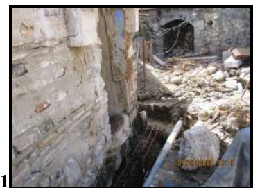
Photo 100: Encadrement par un chaînage en BA, RDC maison 19. Photos 101 : Absence d'appui des piliers. Maison 19 bis. Photo 102 : Libage périphérique extérieur en BA. Bloc Maison 19.
