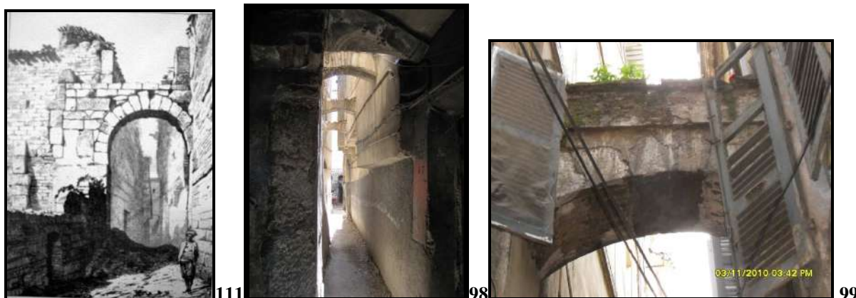
Figure 111 : Gravure laissant paraître un arc entretoisant les constructions de la vieille ville de Constantine. DELAMARE. Photo 98, 99 : Photos de la vieille ville laissant apparaître des arcs de maçonnerie de brique pleine entre les constructions sous les passages étroits.
