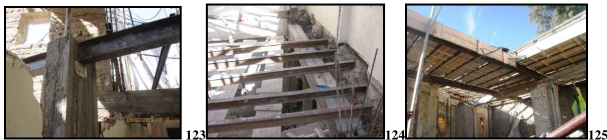
Photo 123 et : Système de plancher des maison. Photo 124 : Pose des IPE principaux. Photo 125 : Les traverses métalliques.
