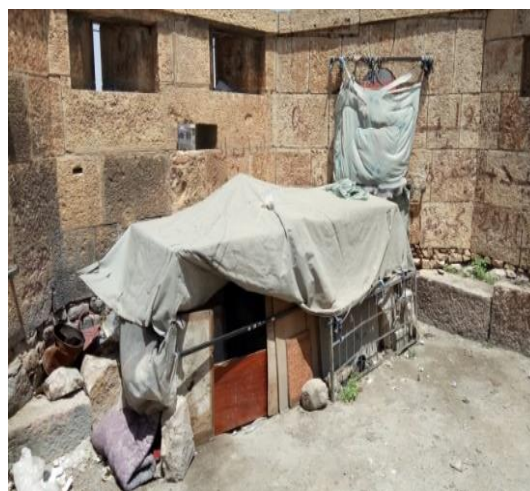
Figure 7.42 : Construction d'un abri sauvage au niveau de la tour d'angle N°1, menaçant ainsi la citadelle byzantine
