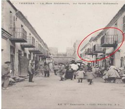
Figure 6.20 : Photo d'archive montrant l'emplacement d'une belle maison coloniale au niveau de la rue de Solomon, avant sa démolition
