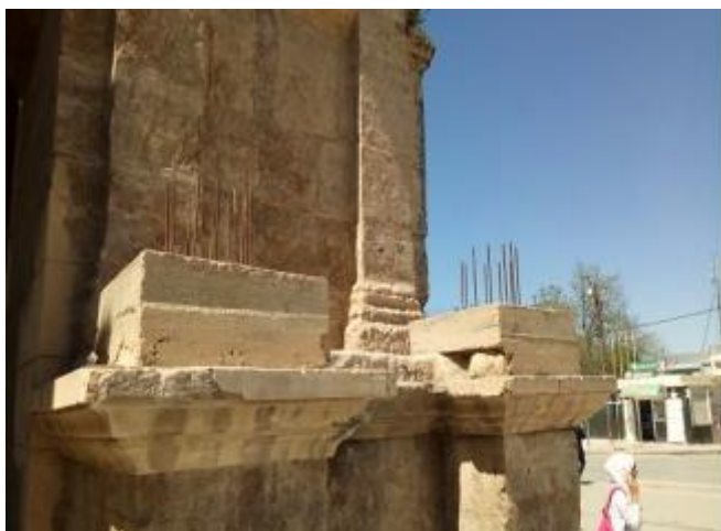
Figure 9.15 : la pose de fer et du béton armée pour la restitution des deux colonnes manquantes de la face Est de l'arc de triomphe de Caracalla
