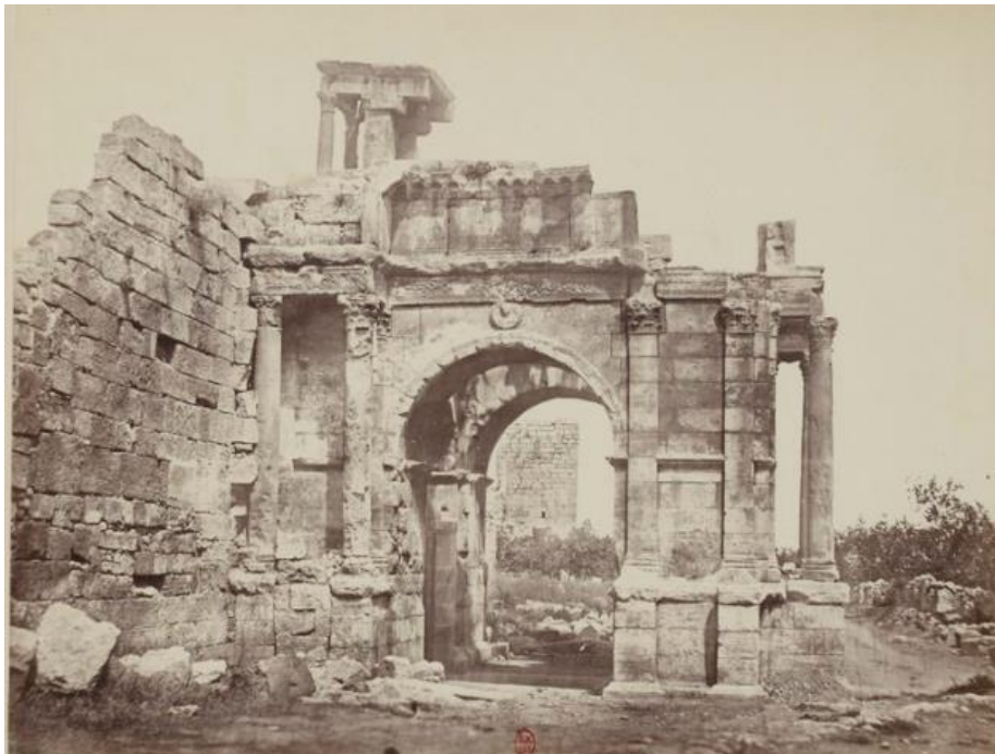
Figure 9.3 : Porte de Caracalla en 1865, deux ans après sa restauration par le capitaine du génie Histein
