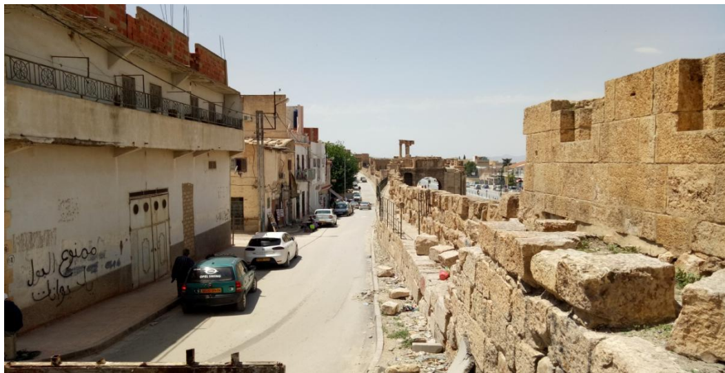
Figure 7.26 : Les dépôts des terres, bien visibles à l'intra-muros jusqu'au niveau du chemin de ronde a engendré l'enfouissement de plusieurs murs du rempart
