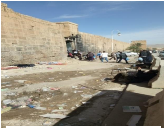
Figure 9.38 : La face Est avant réaménagement
