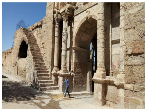
Figure 9.17 : Les quatre colonnes de la façade Sud de l'arc de triomphe de Caracalla recouvertes en plâtre
