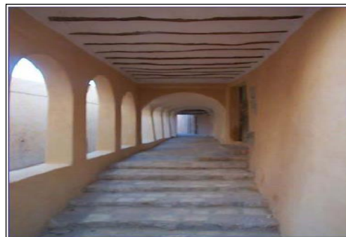
Figure 3.9: Cour du ksar après réhabilitation
