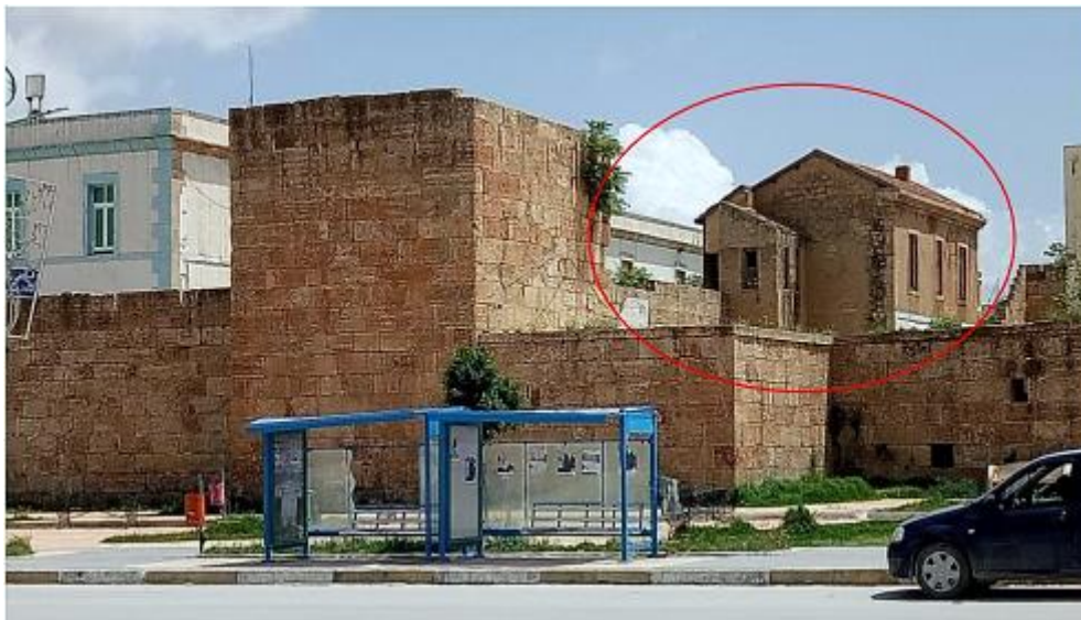
Figure 7.32 : Partie de mur byzantin incorporée dans la structure de bâtisse française de l'école Chamekh Miloud Source :(Auteur, 2022).
