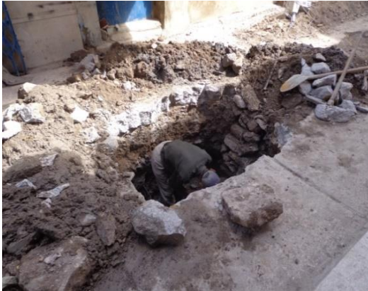
Figure 9.48 : La réfection des réseaux d'assainissement à l'intra-muros
