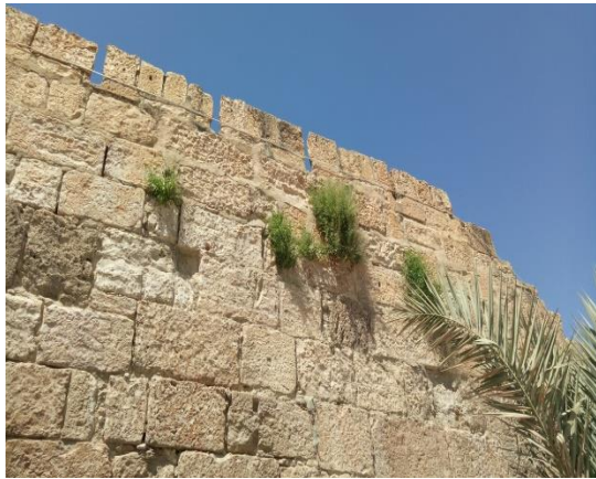
Figure 7.19 : Plantes parasites dans le rempart byzantin
