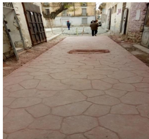
Figure 9.53: La Rue après réfection
