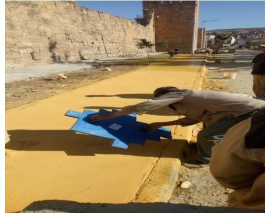
Figure 9.39 : La face Est après réaménagement
