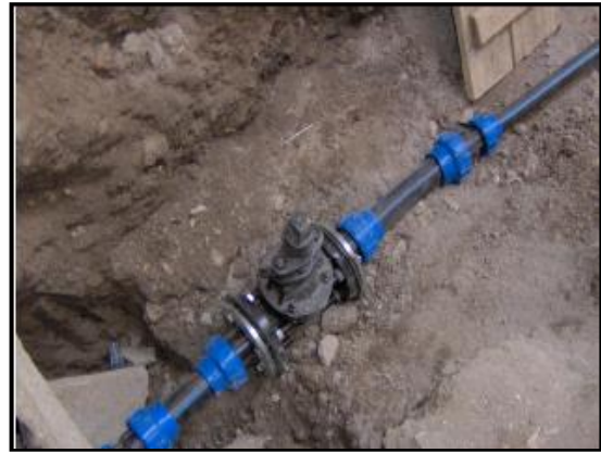
Figure 9.49 : La réfection des réseaux d'AEP
