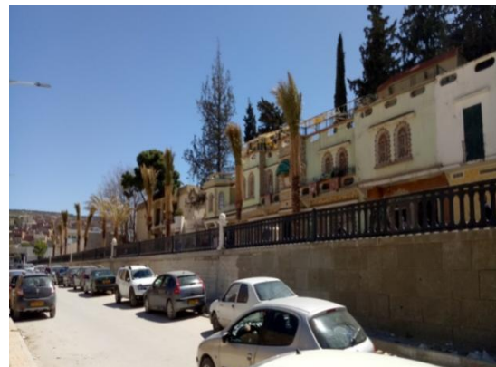
Figure 7.47: Stationnement de part et d'autre dans des rues à sens interdit, rendant la mobilité difficile dans le vieux centre.
