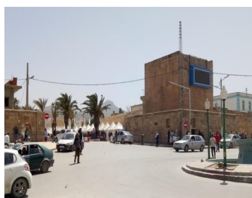
Figure 9.14: La porte de Constantine après sa démolition
