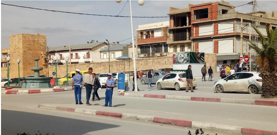
Figure 7.33: Des nouvelles constructions incompatibles avec le caractère architectural du centre historique de Tébessa, en plus d'être plus hautes que le niveau du rempart byzantin Source : (Auteur, 2022).
