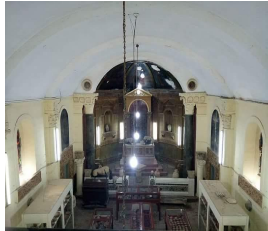
Figure 7.17 : L'intérieur de l'église française (la voûte du chœur, y compris la salle de nef et ses baies vitrées et dessinées
