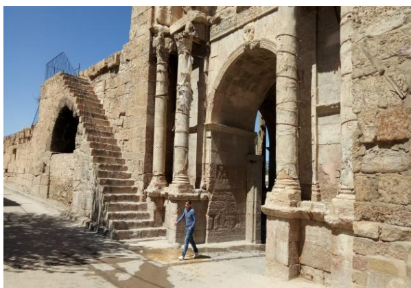
Figure 7.2 : L'intra-muros avec son chemin de ronde et ses escaliers
