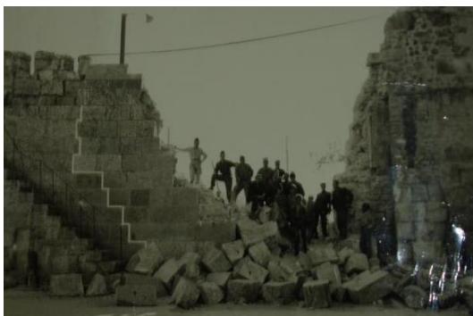
Figure 9.11: La porte de l'horloge au moment de sa démolition en 1957
