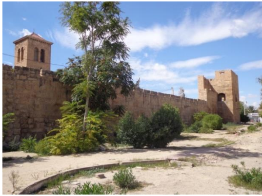
Figure 9.36: La face Nord du rempart byzantin avant réaménagement
