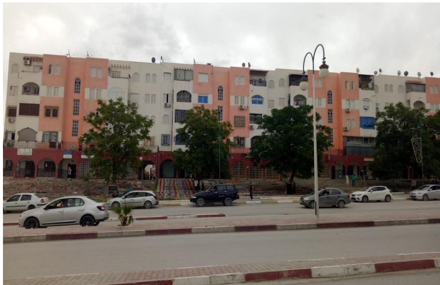
Figure 6.15: La cité d'habitat collectif, appelée cité Theveste, dans le centre historique de Tébessa
