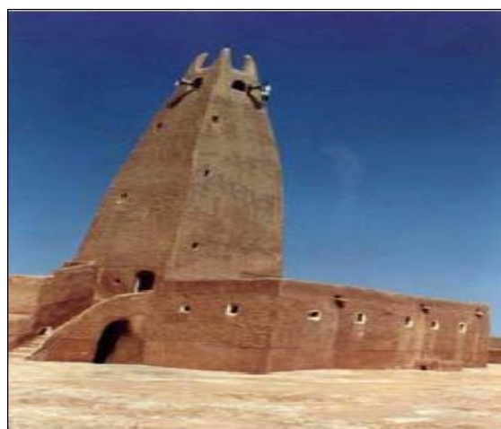
Figures 3.7 : La mosquée de Bounoura après restauration
