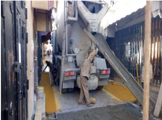
Figure 9.50 : La réfection des voies défectueuses par la technique du béton imprimé, l'exemple de la voie de la porte de Caracalla
