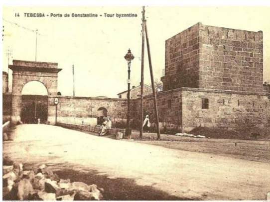
Figure 9.13: La porte de Constantine avant sa démolition
