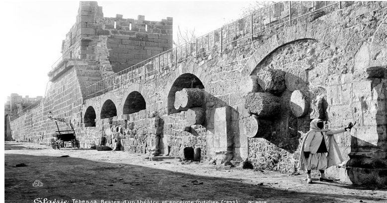
Figure 5.4: Des débris romains intégrés dans le pan Sud-Ouest de la muraille byzantine de Theveste.
