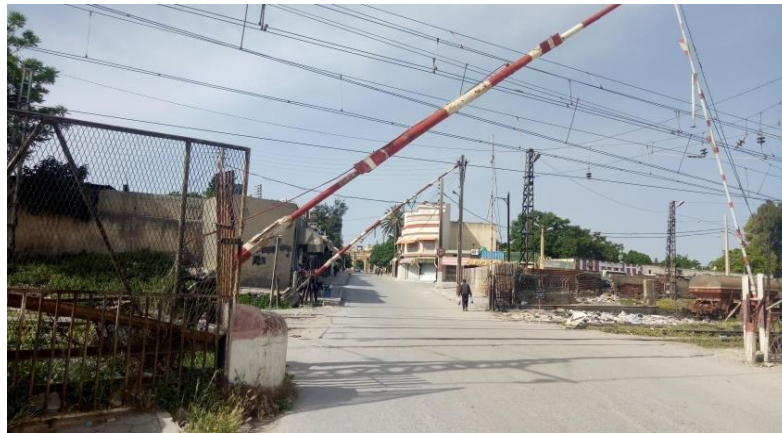
Figure 6.10: La voie ferrée, une coupure urbaine dans le centre historique de Tébessa
