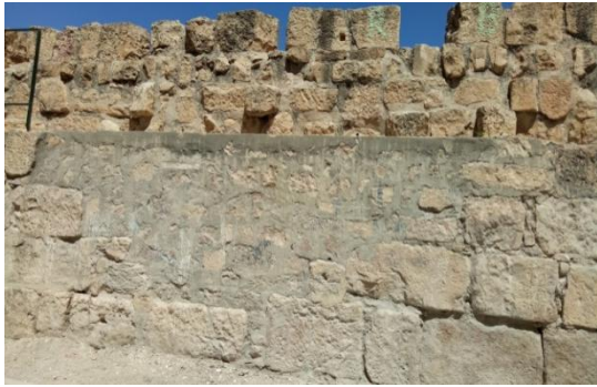
Figure 7.38 : Tentative de consolidation d'une partie du chemin de ronde élaborée à base du mortier de ciment
