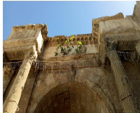
Figure 7.20 : Arbre dont les racines s'incrudent dans la partie supérieure de l'arc de triomphe de Caracalla
