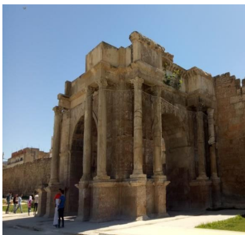
Figure 7.6 : Vue générale sur l'arc de triomphe de Caracalla (faces Nord et Ouest)
