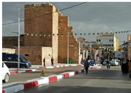
Figure 9.12: état actuel de la porte de l'horloge
