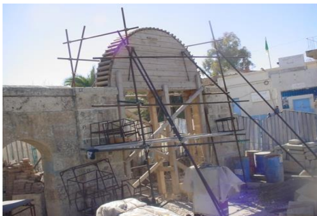
Figure 9.19 : La restauration de la porte de Constantine en cours des travaux
