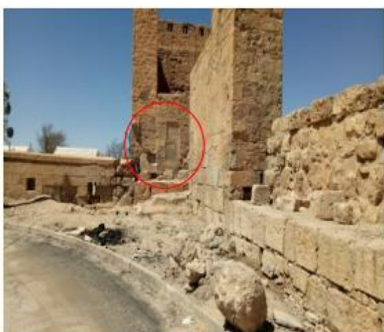
Figure 7.41 : Fermeture par le béton armé de l'entrée de la tour d'angle N°12
