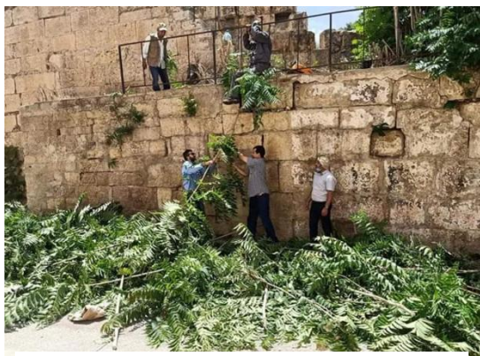
Figure 9.23 : Le désherbage du rempart byzantin
