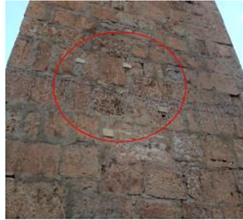
Figure 7.23 : Pose de témoins pour le contrôle des fissures
