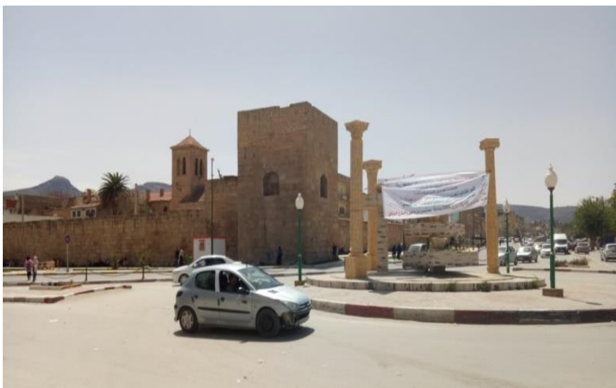
Figure 9.33: Réaménagement des giratoires dans le centre historique de Tébessa Source : (auteur, 2022).
