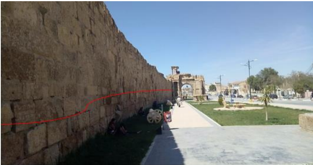
Figure 7.25 : Le gondolement du pan de muraille 13, à cause des poussés de terres Source :(Auteur, 2022).
