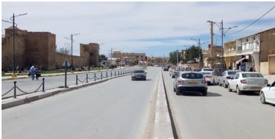
Figure 9.30 : La réfection des voiries à l'extra-muros du centre historique de Tébessa Source : (auteur, 2022).
