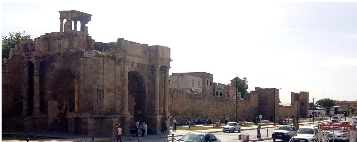
Figure 7.1: Vue extra-muros sur le rempart byzantin avec sa porte de Caracalla et ses tours Source : (Auteur. 2022).
