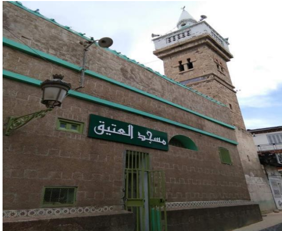
Figure 7.14 : La façade principale de la mosquée El Atiq
