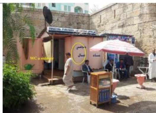
Figure 9.28 : état des nuisances du rempart byzantin avant son réaménagement
