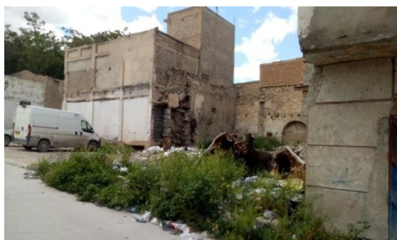
Figure 6.24 : La destruction intégrale des maisons, entraînant des poches vides, défigurant ainsi l'homogénéité du centre historique de Tébessa
