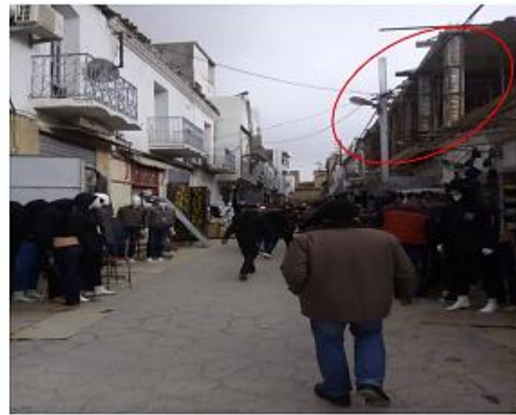
Figure 6.21 : Photo aujourd'hui montrant la démolition de l'ancienne maison au profit de la reconstruction d'un bâtiment moderne dans la même rue
