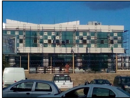
Figure 5.15 : Travaux de réhabilitation Source : (Auteur, 2014)
