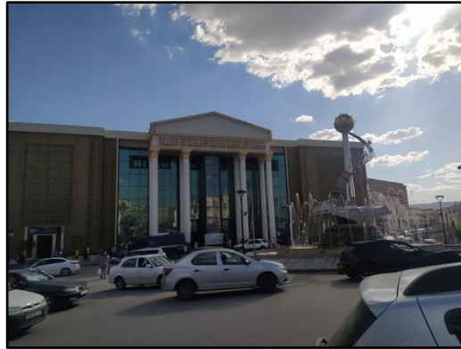
Figure 5.19 : palais de la culture el Khalifa après aménagement Source : (Auteur, 2019)
