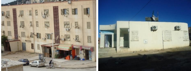
3-29. Les locaux commerciaux de Ben Mhidi et le siège (APC + unité de soins)
