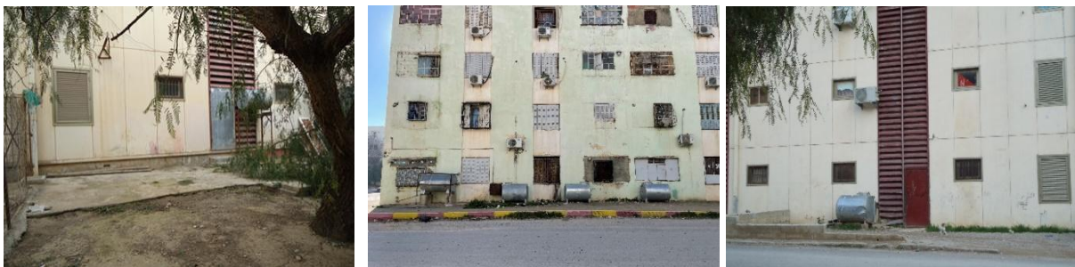
7-71. Installation de réservoirs sur l'espace limitrophe
