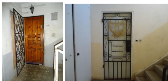
7-1. Le renforcement des portes sous-dimensionnées
