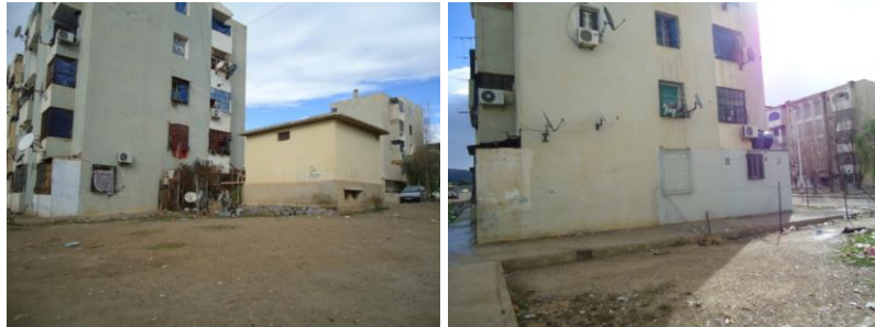
7-67. Ouverture de fenêtres sur façades.
