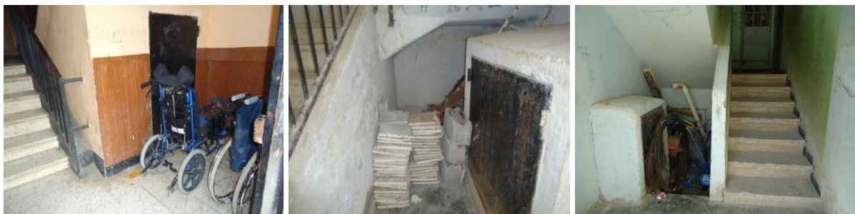
7-54. Surinvestissement du hall d'entrée de l'immeuble
