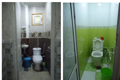
6-27. Modernisation des WC
