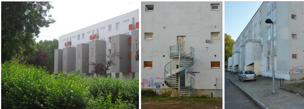
8-20. Réhabilitation inachevée des logements.
