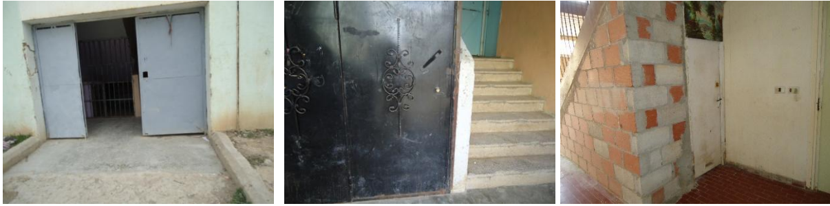
7-55. Entretien du portail et privatisation des espaces sous l'escalier
