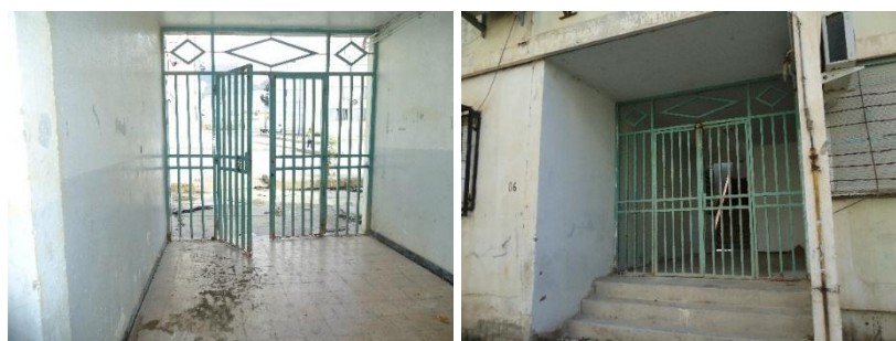
6-29. Ferméture du second portail de l'immeuble
