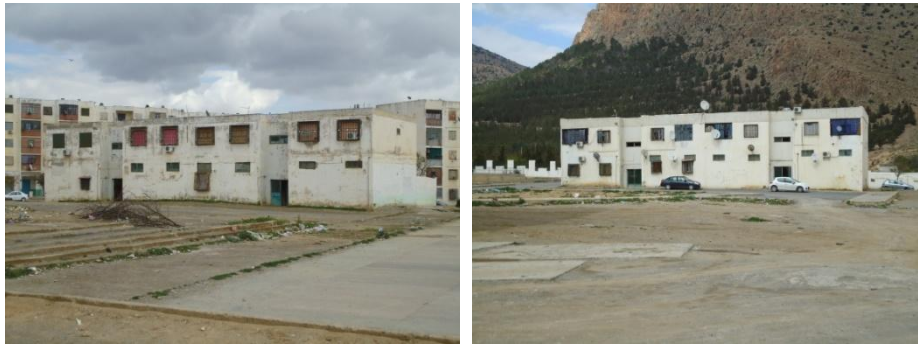
Figures N° 4 et 5 : Immeubles inachevés
