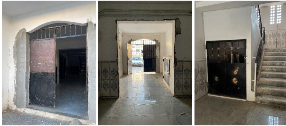
6-42. Changement de position du portail, Fermeture de l'espace sous la volée
