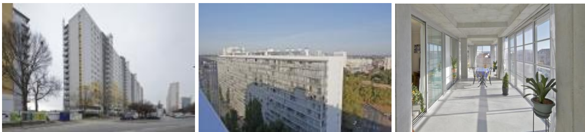
8-14. Réhabilitation de la cité du Grand Parc.
