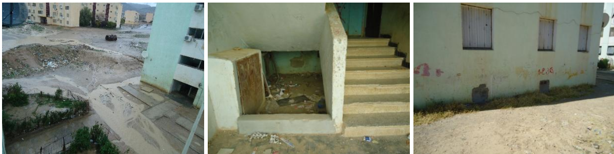
7-56. Inondations de la cité Ben Mhidi et intervention des habitants
