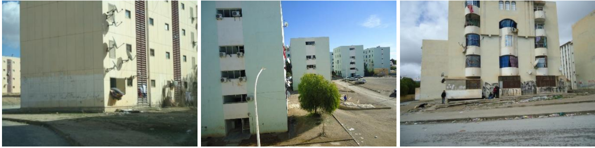
7-64. Polyvalence de la façade à Ben Mhidi
