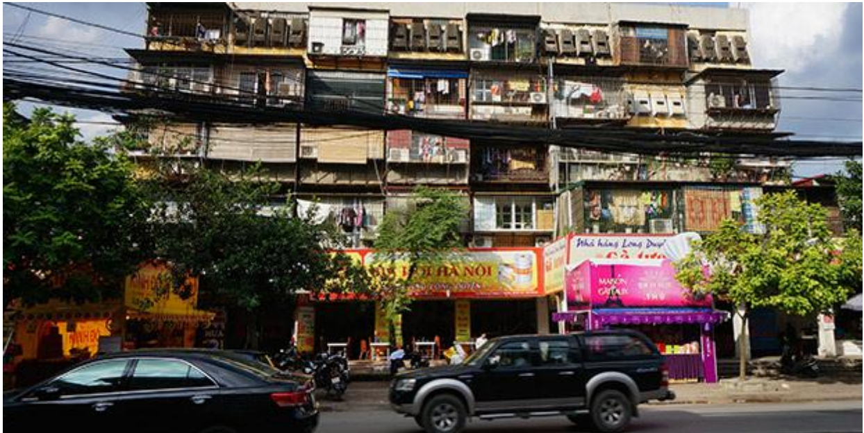
11-2. Façade transformée d'un immeuble
