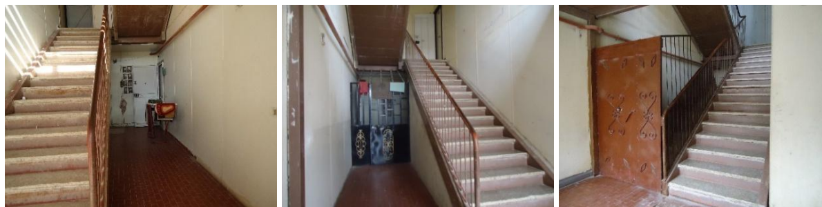
7-17. Renforcement de l'entrée par une porte en fer ou un grillage métallique
