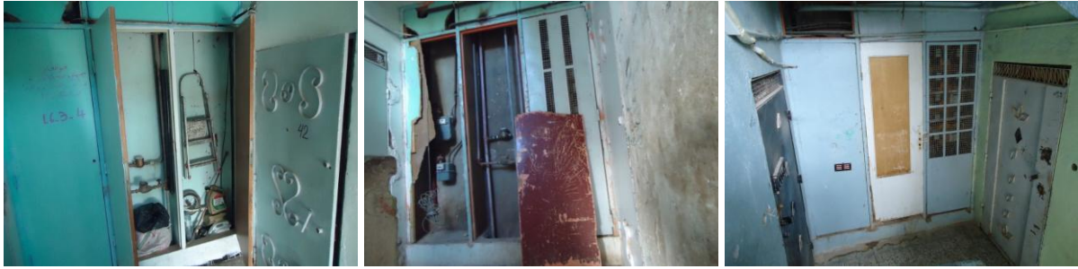
7-60. De l'utilisation de la gaine technique vers la réparation
