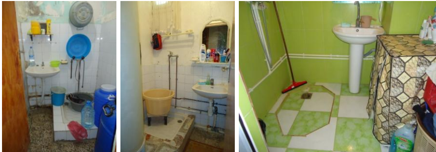
7-43. Elimination de la cuvette de douche.
