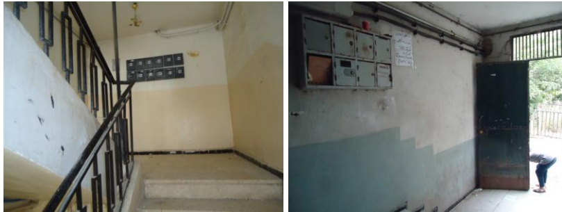
6-30. La fixation des boîtes à lettres dans le hall d'entrée
