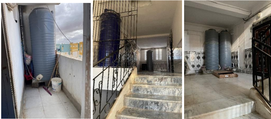
6-39. Installation de réservoir dans le séchoir ou sur le palier d'étage
