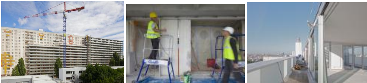
8-10. Vues des extensions des logements de la cité du Grand Parc.
