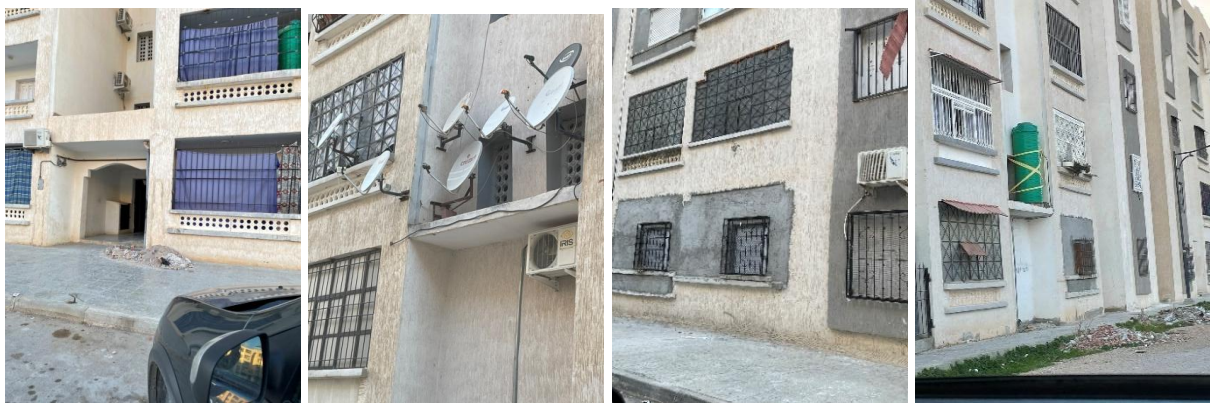
6-44. Appropriation des façades, Installation de paraboles et rideaux.
