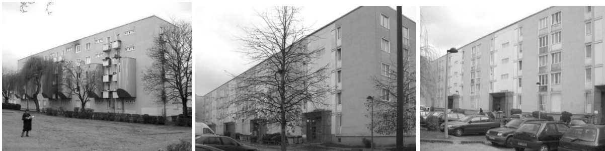
8-16. Vues de la cité Beaulieu avant réhabilitation
