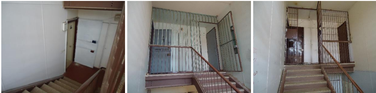
7-19. Renforcement de l'entrée au dernier étage
