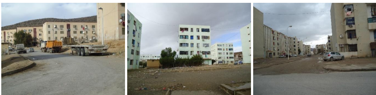
3-28. Vues sur les trois tranches de Ben Mhidi
