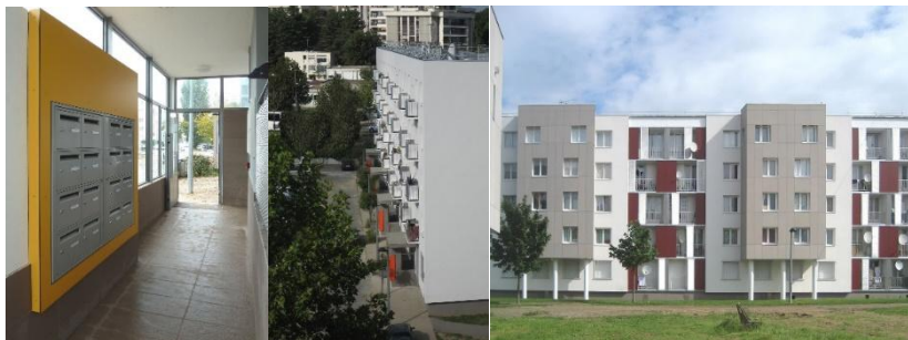
8-19. La cité Beaulieu après réhabilitation.
