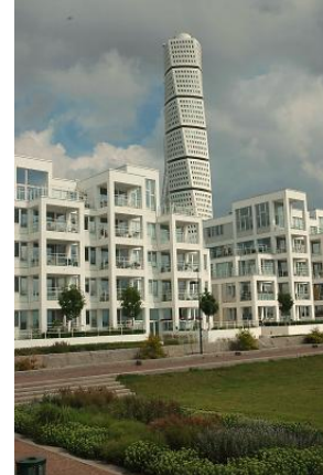
Figure.2.4. Grandes ouvertures et bords vitrés des bâtiments de quartier Bo01 (Source : Austin, 2013)
