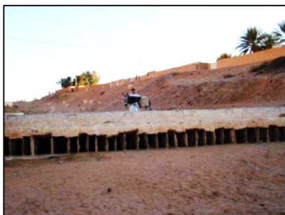
Figure.5.14 : Système de répartition des eaux des crues (Tissanbadh) (Source : Remini, 2020)
