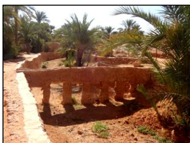
Figure.5.11 : Peigne-répartiteur dans la palmeraie de Ben-Isguen (Source : Gueliane, 2019c)
