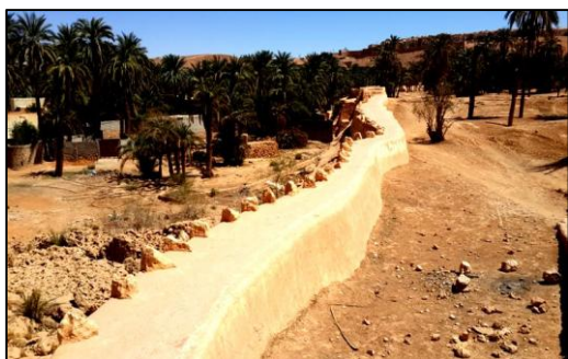
Figure.5.9 : Barrage de rétention des eaux des crues de Beni-Isguen (Source : auteure, 2018)
