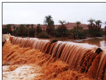
Figure.5.10 : Barrage de Beni-Isguen pendant la crue (Source : Anonyme, Non datée)
