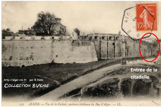
Figure 5.22 . Muraille Est de la Citadelle, source : www.algerroi.fr
