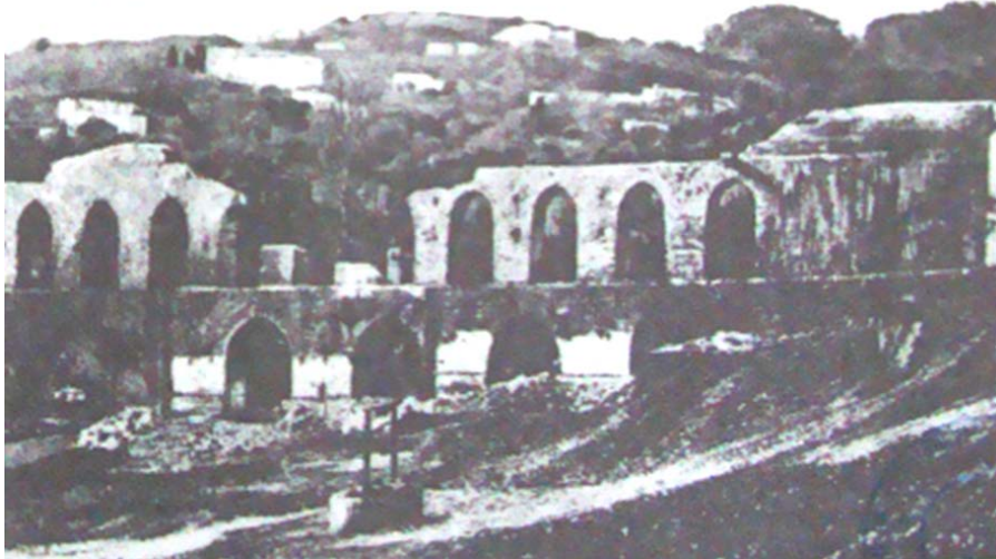
Figure 6.3. Aqueduc du Hamma, source : MISSOUM Sakina, 2003, p 103
