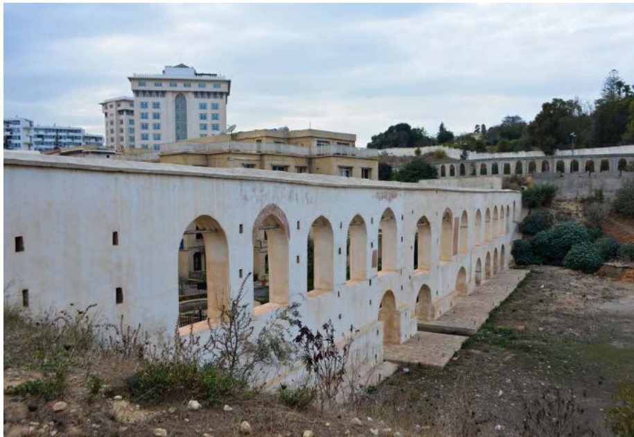
Figure 6.4. Aqueduc de Ayn Zabouja, source : prise par l'auteur
