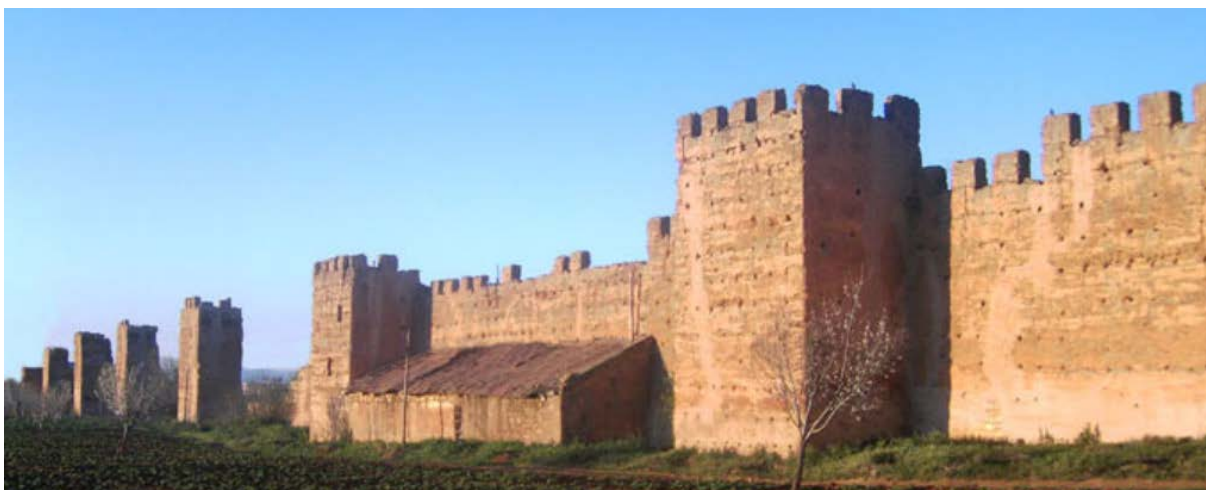
Figure 3.23. L'enceinte de Mansourah à Tlemcen. Source : photo prise par l'auteur
