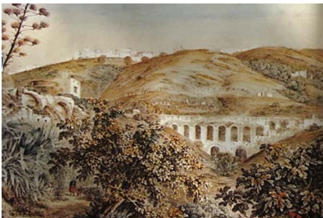
Figure 4.20. Les aqueducs d'Alger, source : BNA, Photos personnelles
