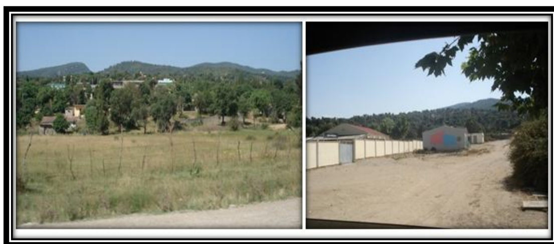
Figure 5. 17: Vues générales sur l'agglomération de Laaraba.
