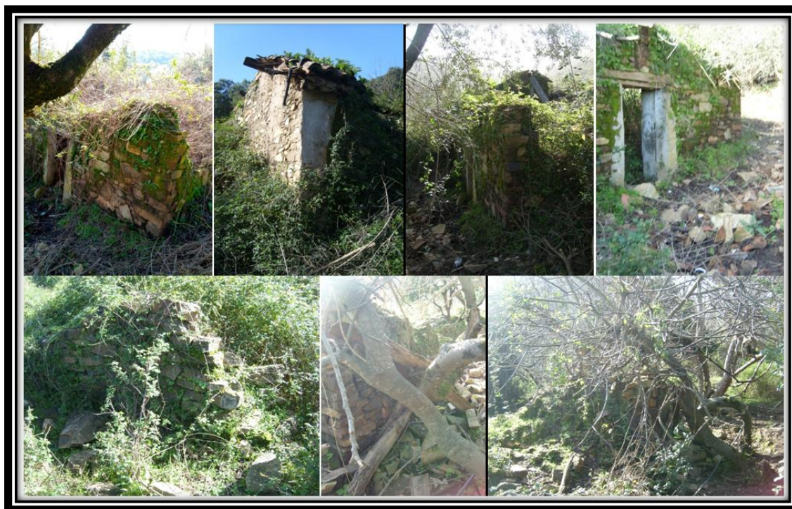
Figure 8. 6: Mechta Djârît abandonnée et totalement en ruine.
