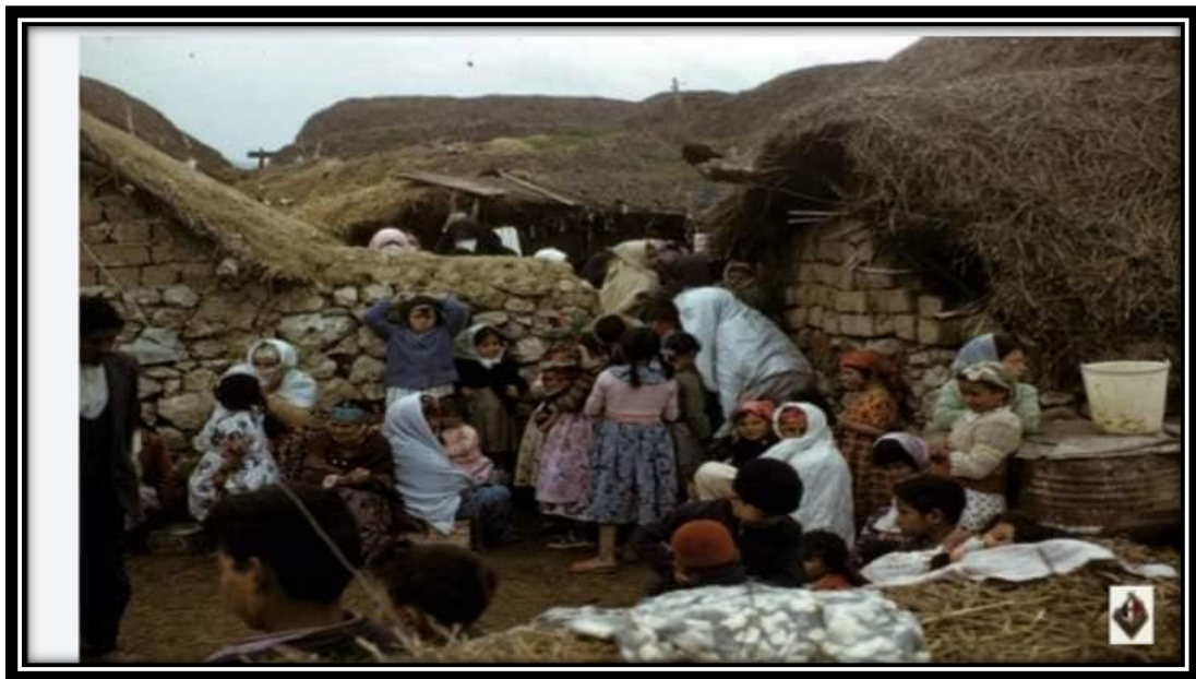
Figure 6. 5 : Gourbis en pierres maçonnées avec un toit de chaume ou de diss, Jijel.
