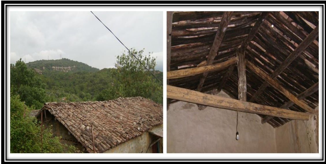
Figure 6. 8: Couverture en tuile et le détail de la charpente de bois.
