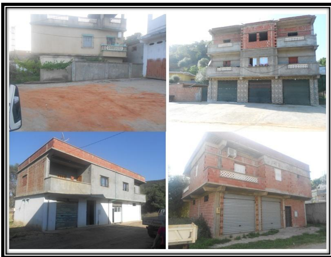
Figure 8. 14: Exemples de nouvelles constructions au niveau la mechta Ouled Echelli Source : Auteure, 2024.
